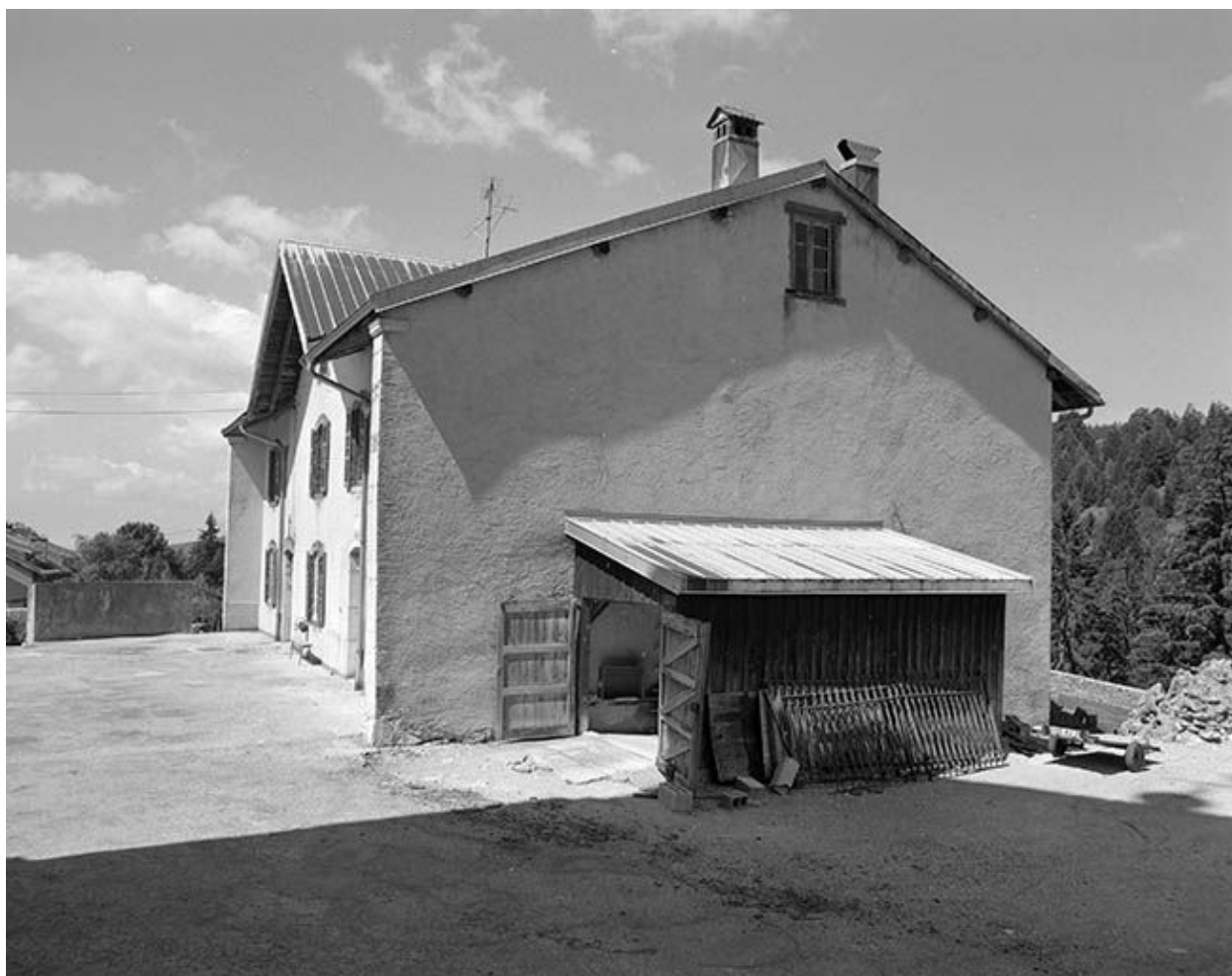
Façade antérieure et face droite.
