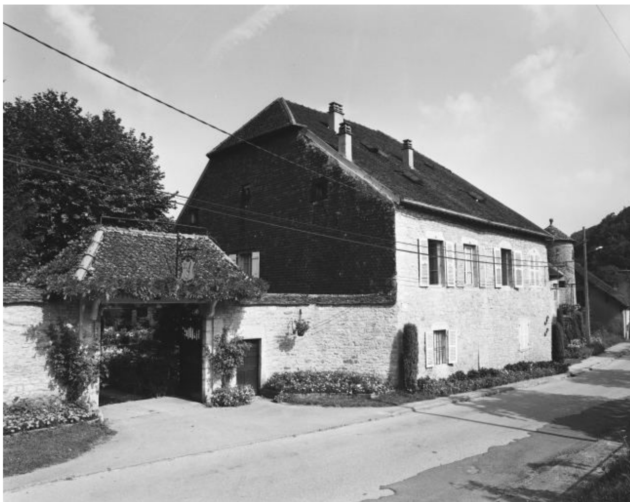
Bâtiment d'habitation vu depuis la rue.
