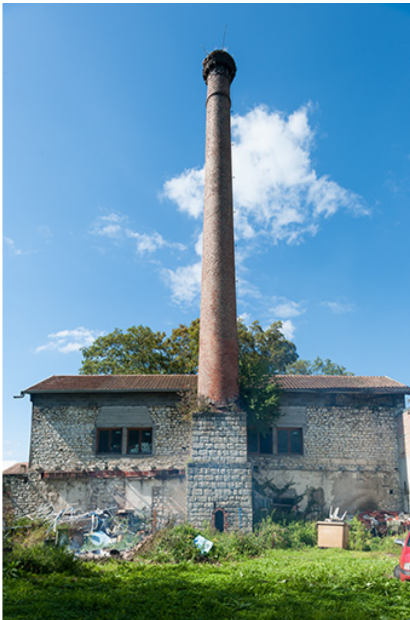
Façade sud de l'atelier de fabrication.
