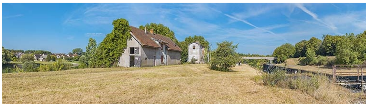
L'ancienne écluse vue depuis l'amont.
