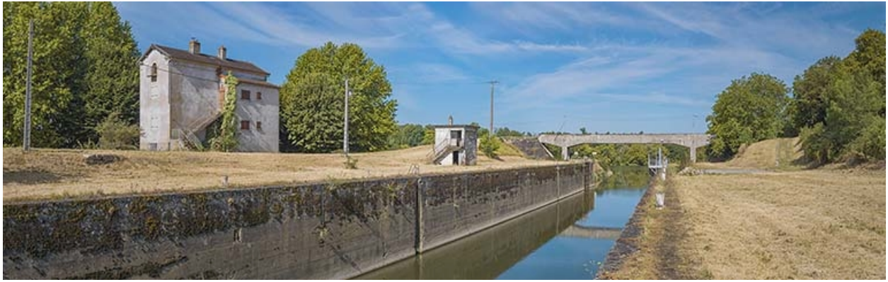
Le sas de l'ancienne écluse.
