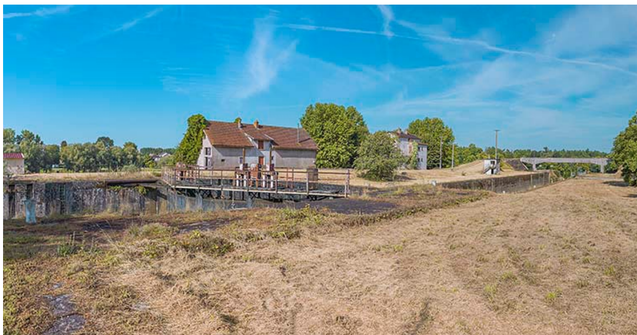
Vue d'ensemble du site d'écluse depuis l'amont.
