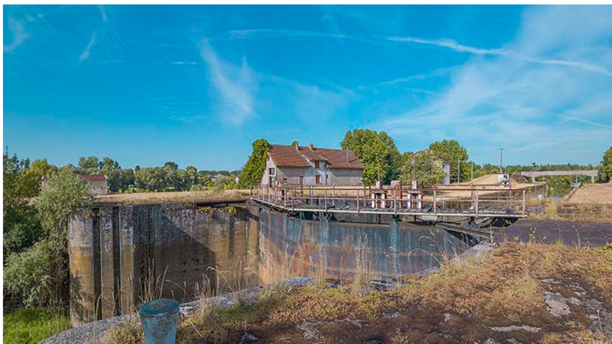
Les portes amont de l'ancienne écluse.
