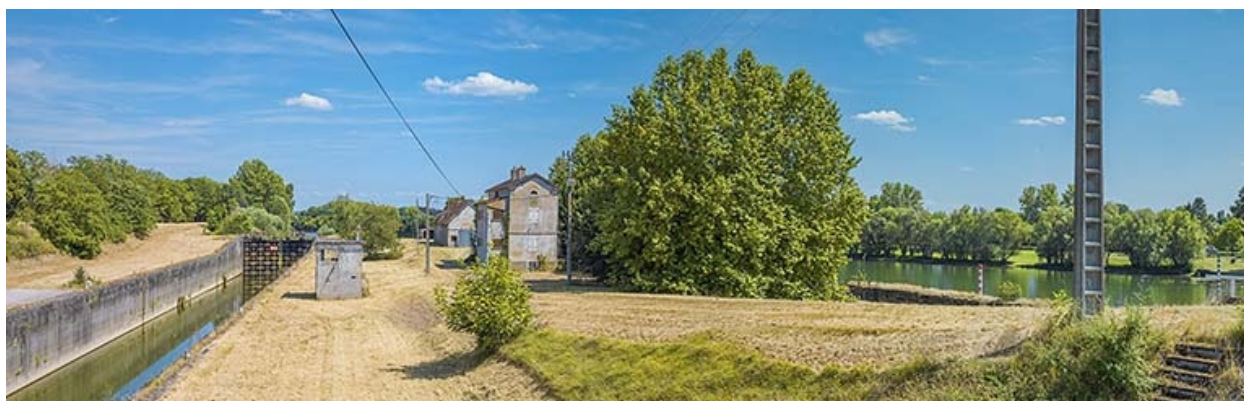
Vue d'ensemble du site d'écluse depuis l'aval.
