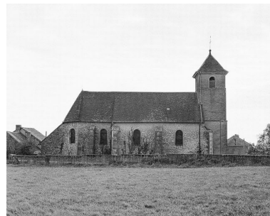
Façade latérale gauche. Phot. Yves Sancey IVR43_19753900617X
