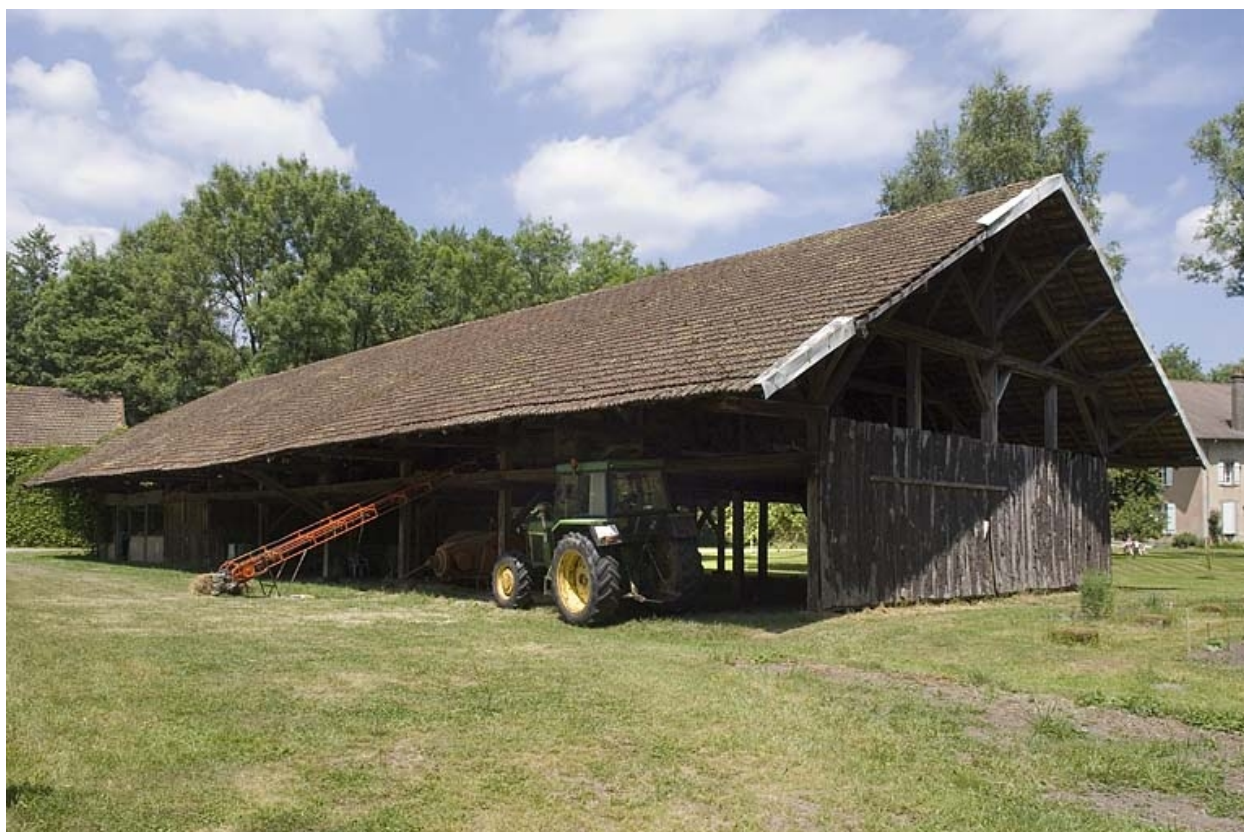
Entrepôt industriel vu depuis le sud.
