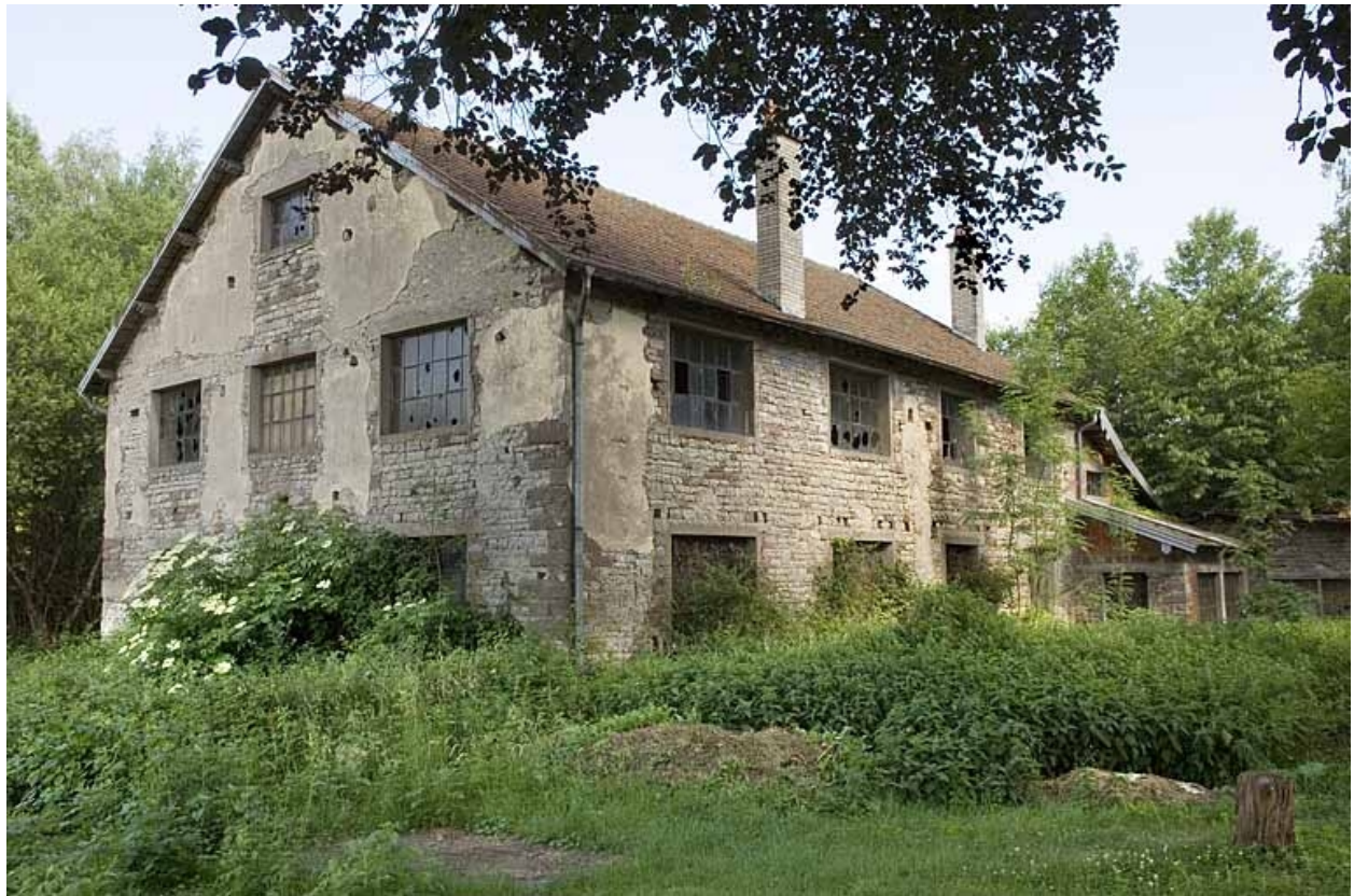
Bureau (?) depuis l'ouest.
