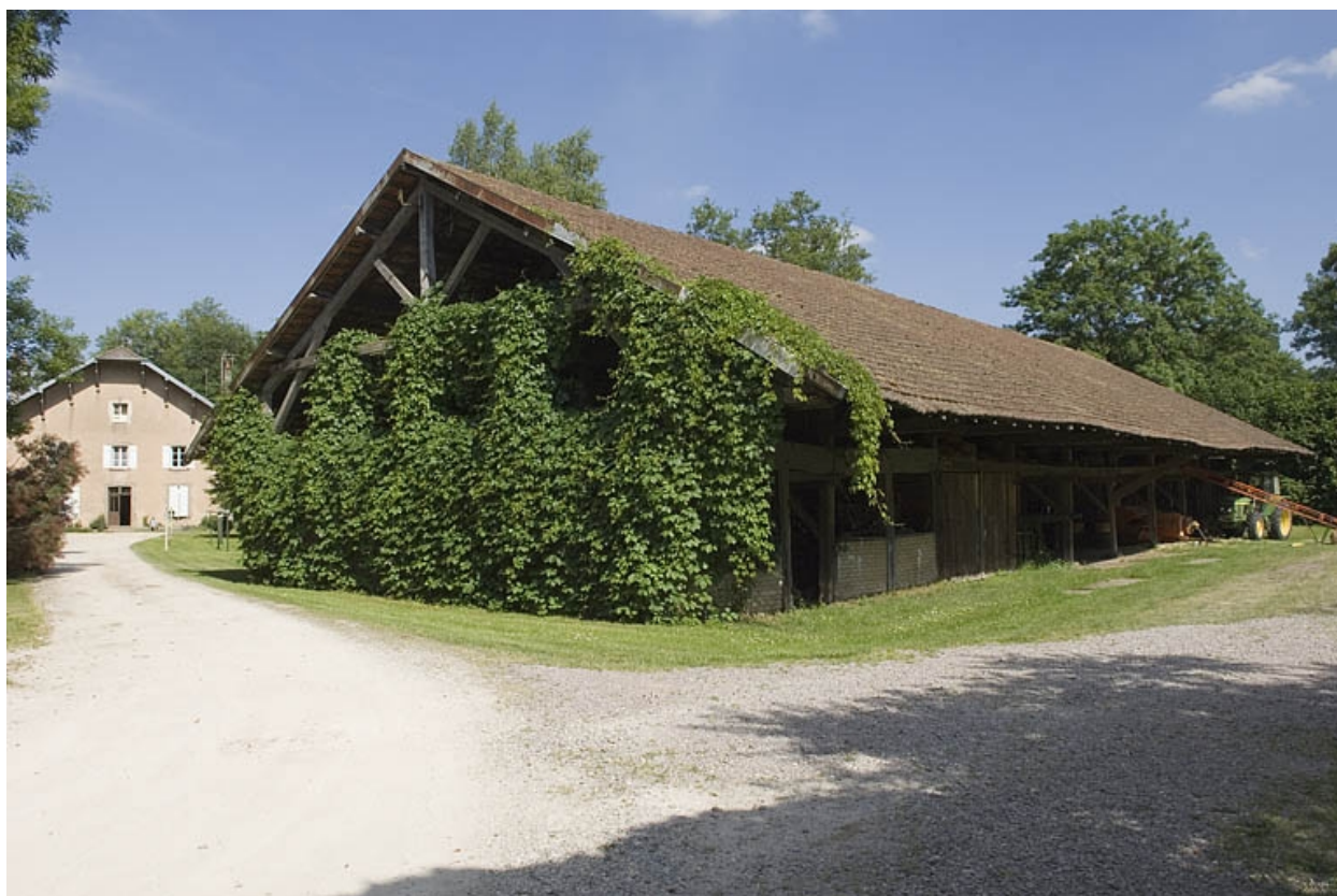
Entrepôt industriel vu depuis l'ouest.
