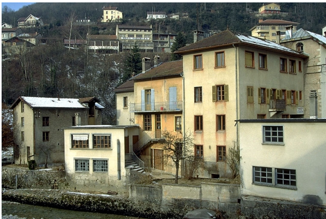
Bâtiments vus de l'est.
