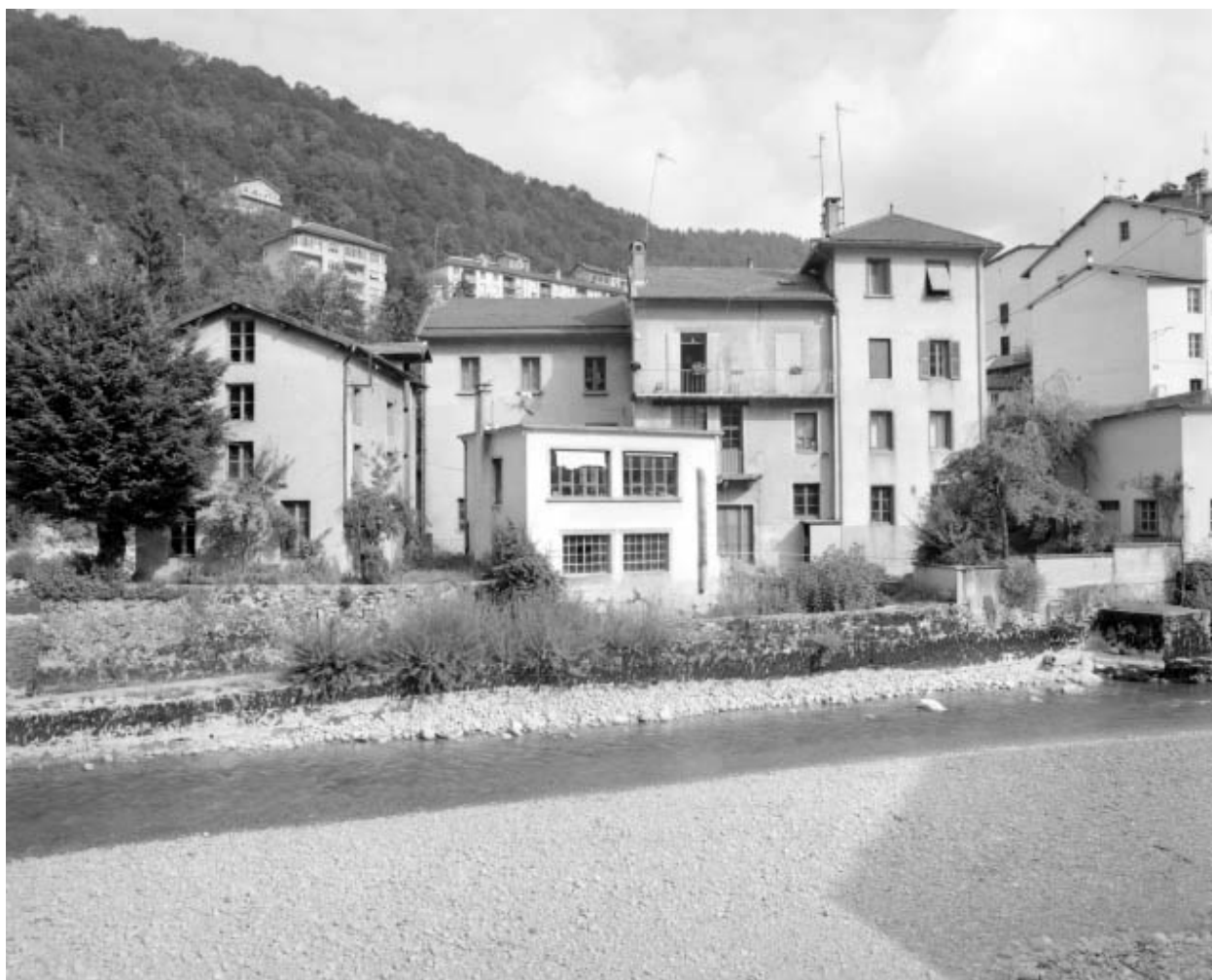
Bâtiments vus du sud-est.
