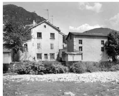
Bâtiments vus de l'ouest. Phot. Jérôme Mongreville IVR43_19923900558X
