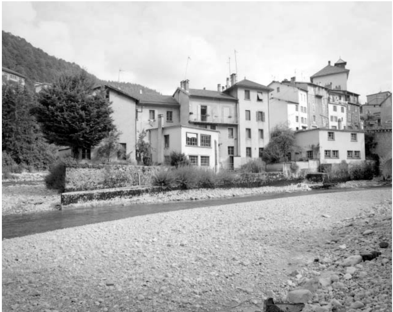
Bâtiments vus du sud.
