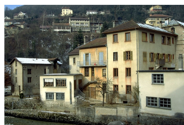
Bâtiments vus de l'est.
