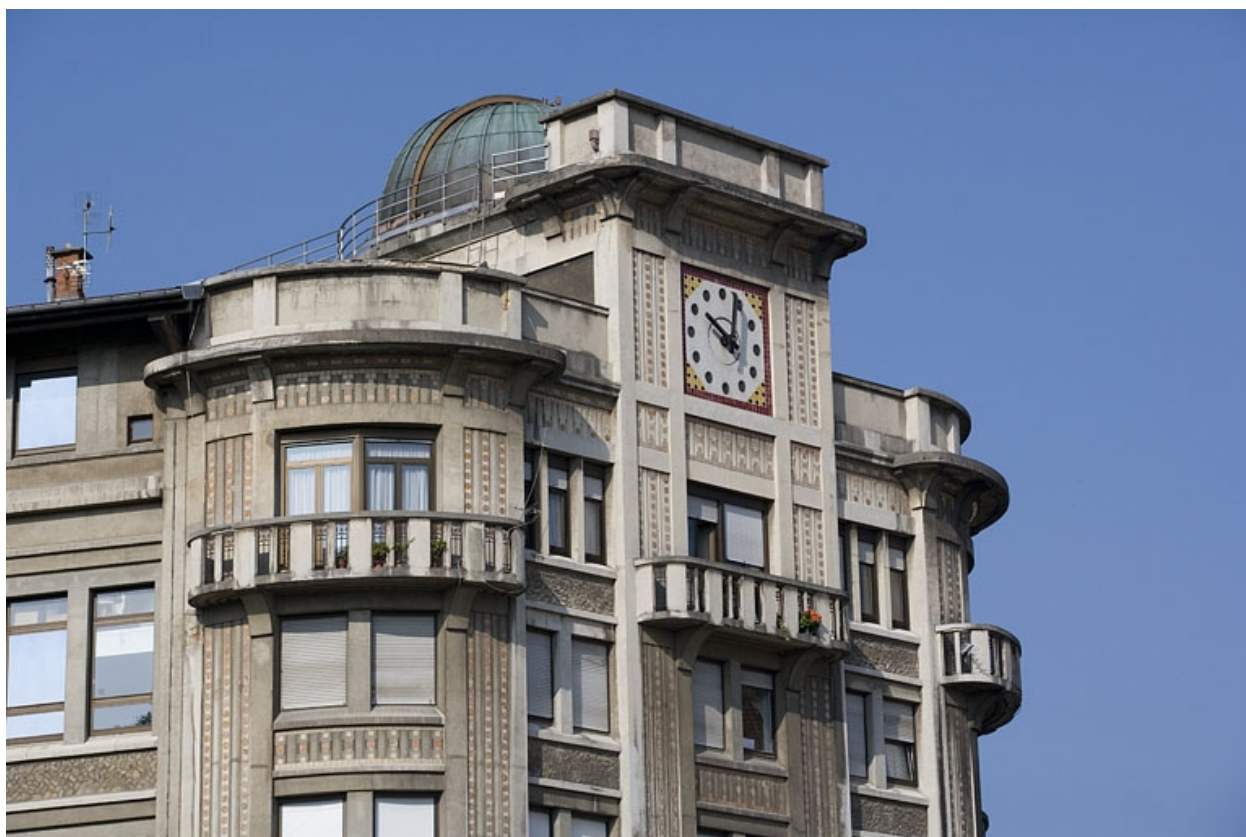
Partie supérieure du corps d'entrée et horloge.
