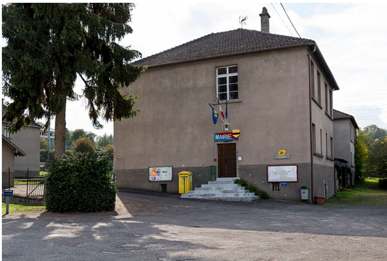
Pignon d'entrée nord-est de la mairie.
