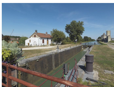
Panorama du site de l'écluse 113 du versant Yonne, dite de Cheny à Migennes, pris d'aval, du pont sur écluse. De gauche à droite : site d'écluse, silos. Le bief est vide : on voit la maçonnerie des bajoyers. Phot. Thierry Kuntz IVR26_20128900613NUC4A
