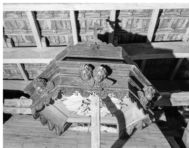
Détail : abat-voix. Phot. Yves Sancey IVR43_19753900050X
