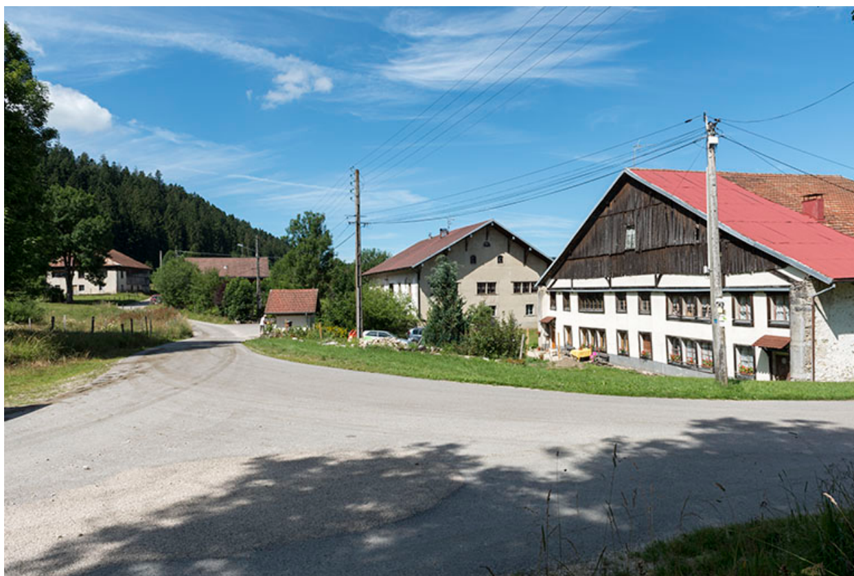
Vue d'ensemble des Seignes, depuis l'est.
