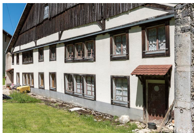
Façade antérieure, vue en enfilade. Phot. Sonia Dourlot IVR43_20172500771NUC4A
