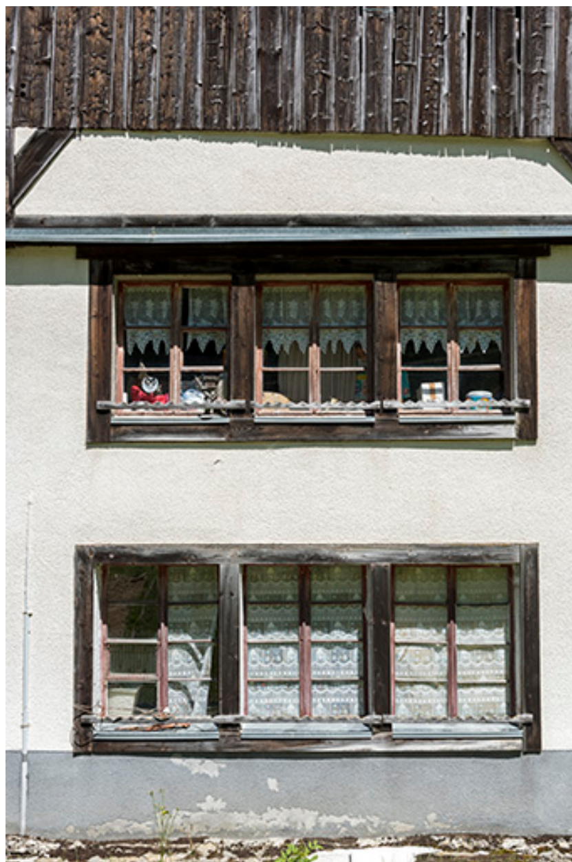
Façade antérieure : fenêtres multiples.
