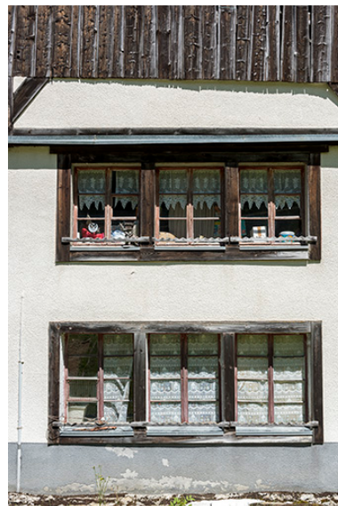
Façade antérieure : fenêtres multiples. Phot. Sonia Dourlot IVR43_20172500772NUC4A
