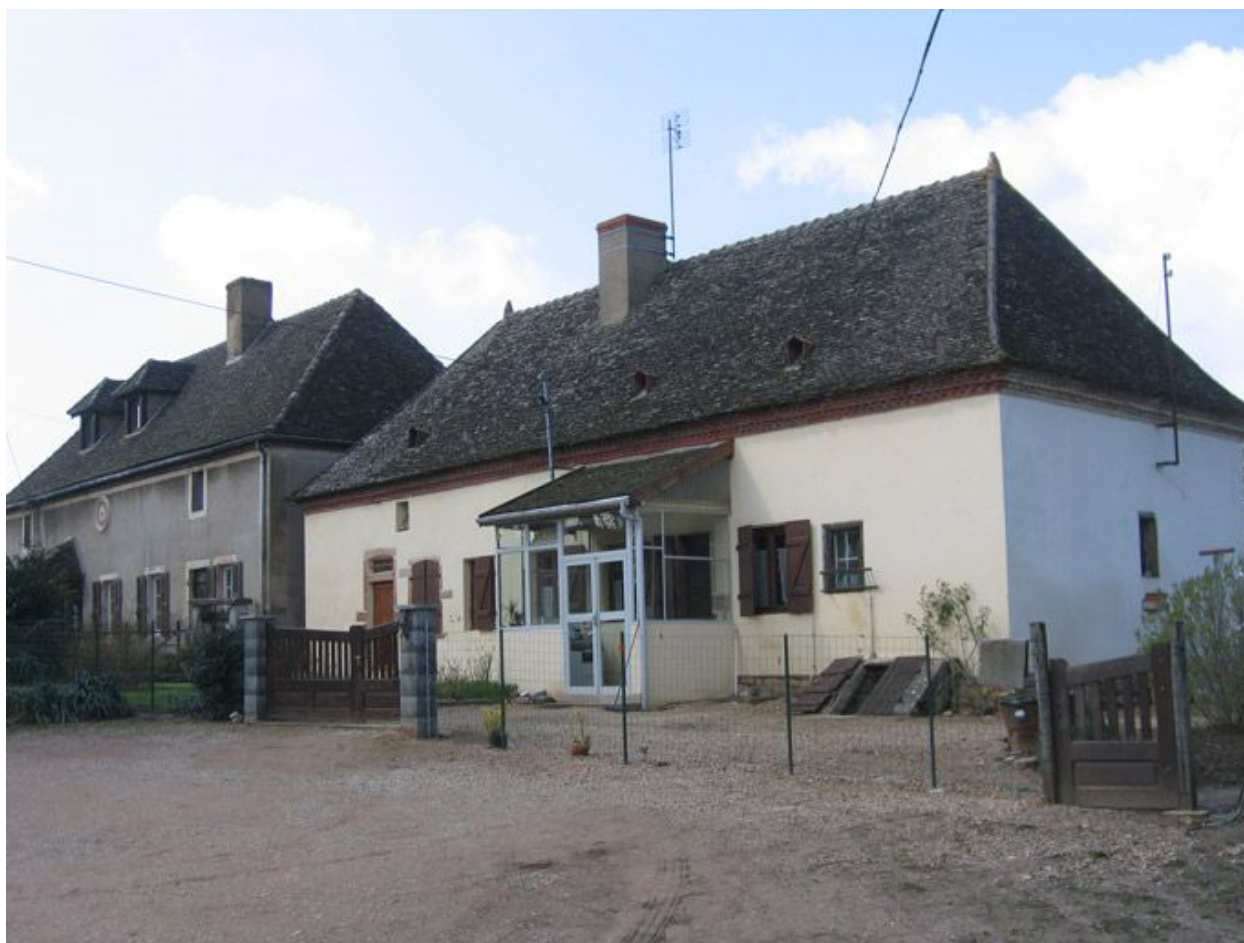
Vue d'ensemble de la façade.
