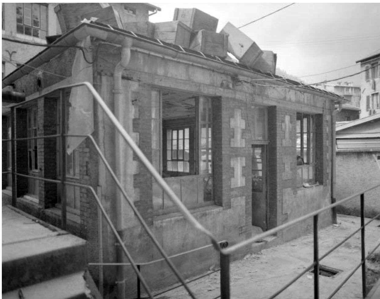
Atelier dans la cour : façade antérieure.
