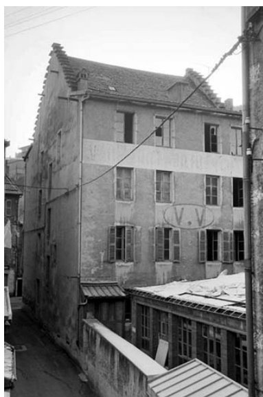
Immeuble : façade postérieure de trois quarts gauche. Phot. Laurent Poupard IVR43_19913901622Z
