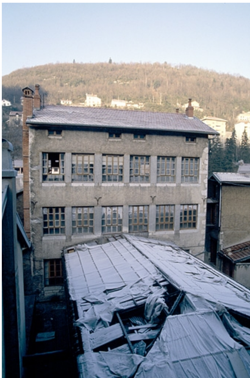
Atelier de fabrication : façade antérieure.
