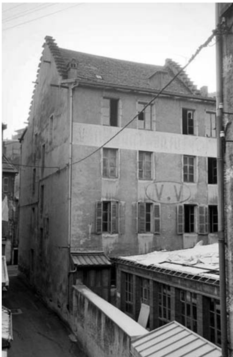
Immeuble : façade postérieure de trois quarts gauche.
