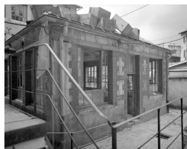
Atelier dans la cour : façade antérieure. Phot. Jérôme Mongreville IVR43_19923900343X
