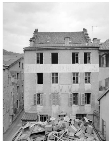
Immeuble : façade postérieure. Phot. Jérôme Mongreville IVR43_19923900341X
