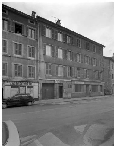
Immeuble : façade antérieure. Phot. Jérôme Mongreville IVR43_19923900338V
