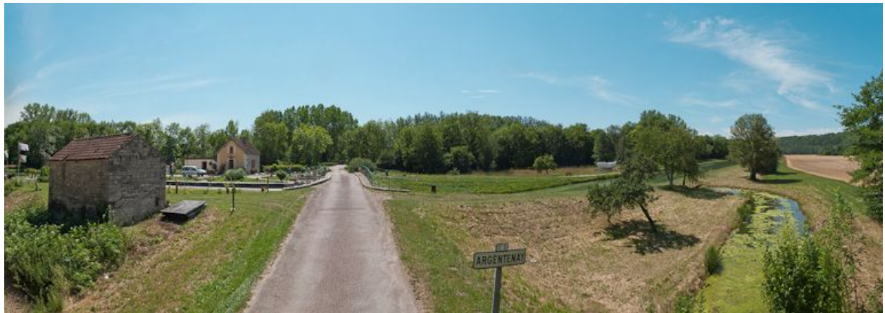
Vue du site d'écluse et de la rigole se déversant en aval.
