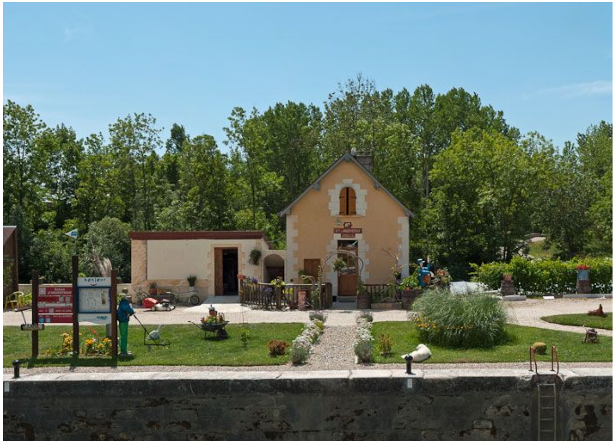
Vue d'ensemble du site d'écluse.
