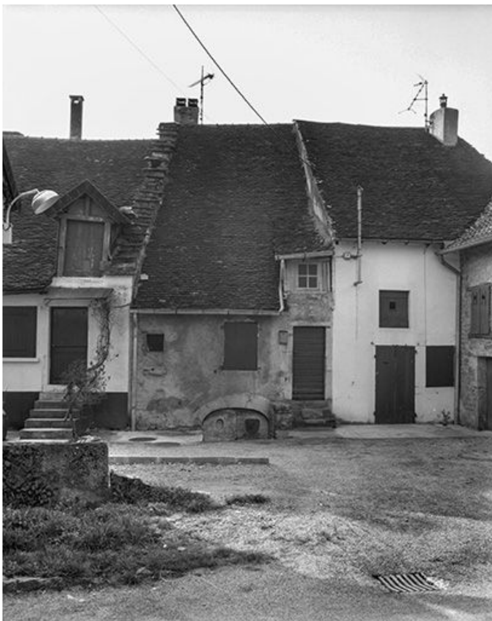
Maison de vigneron située route de Montmorot.
