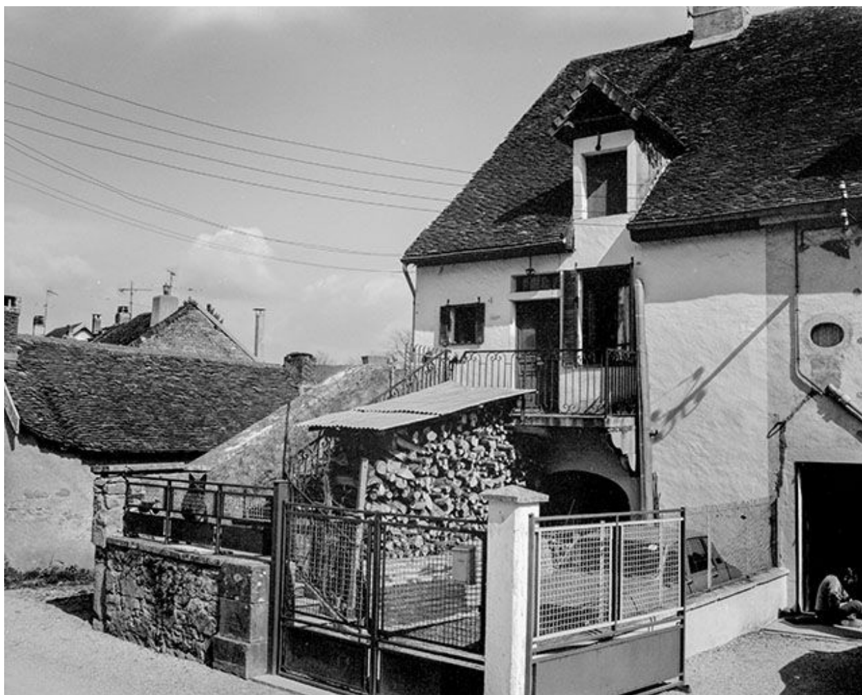
Maison de vigneron située route de Montmoroat.
