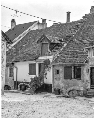
Maison : façade antérieure. Phot. Yves Sancey IVR43_19843900050X
