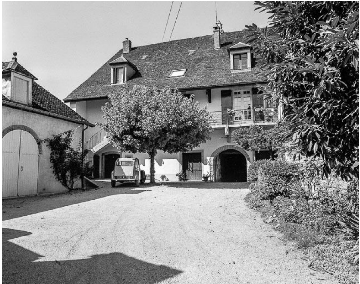
Maison de vigneron située route du Sud Revermont.
