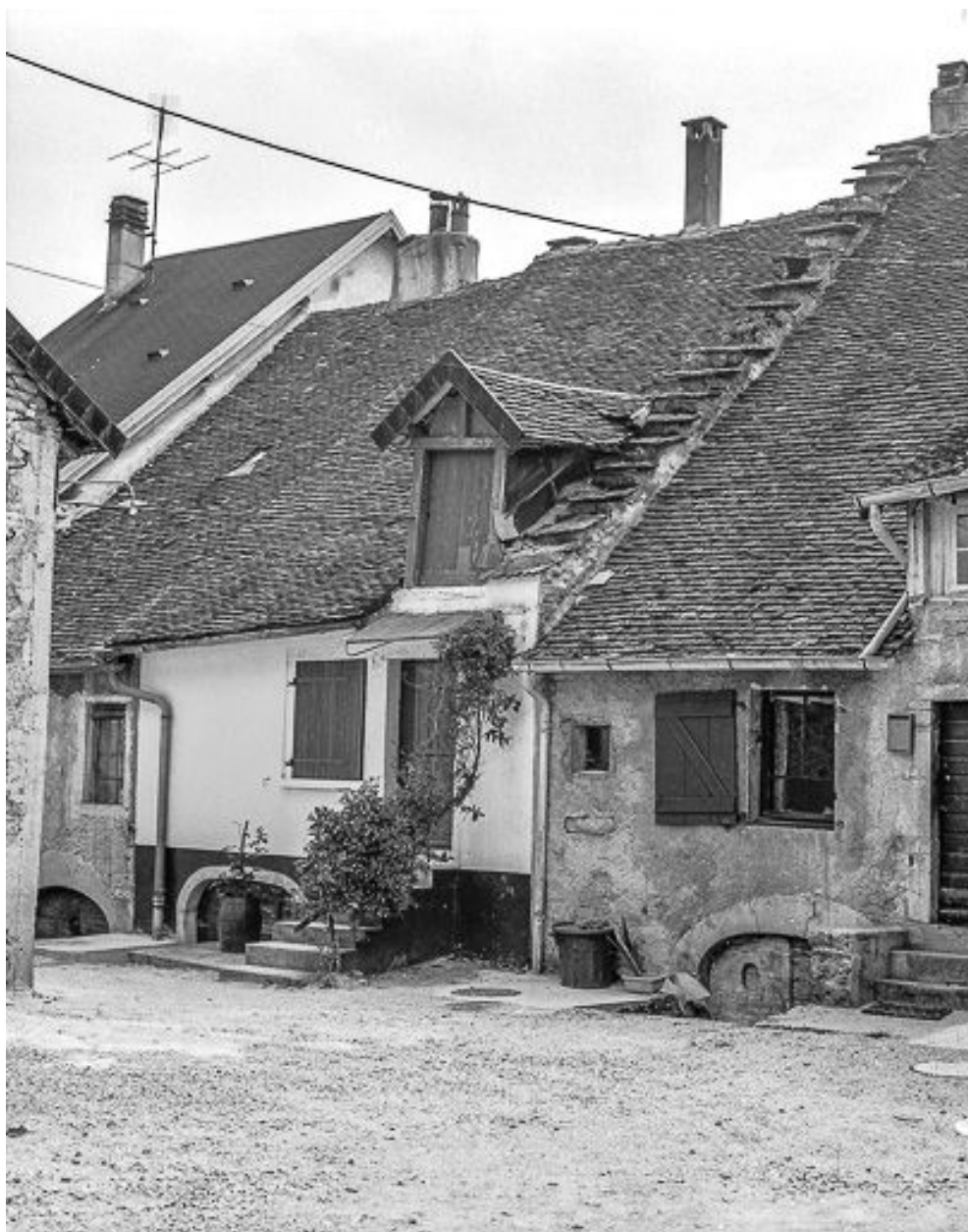
Maison : façade antérieure.
