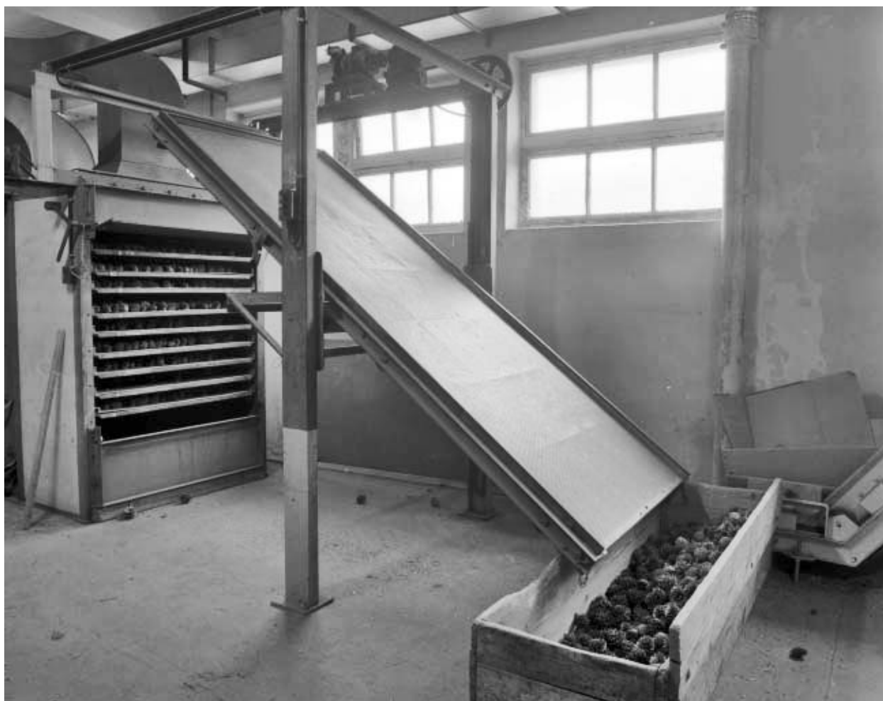
Séchoir ouvert et grille basculée.
