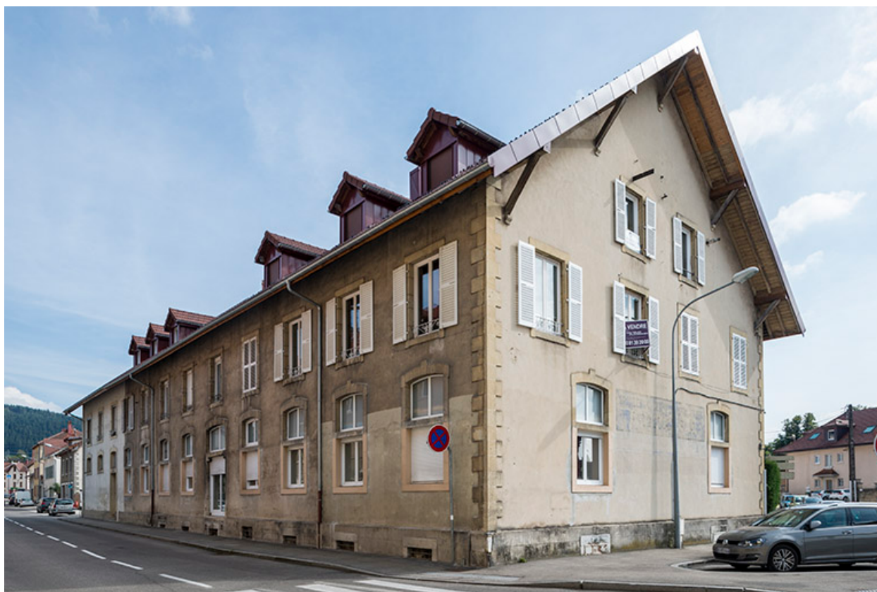
Façade nord et pignon ouest.
