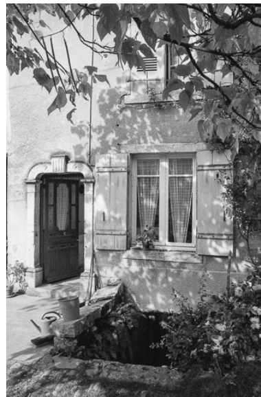
Détail : entrées de cave et d'habitation. Phot. Bernard Lardière IVR43_19797000183Z
