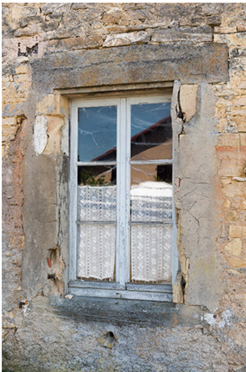
Détail d'une ouverture, mur pignon.
