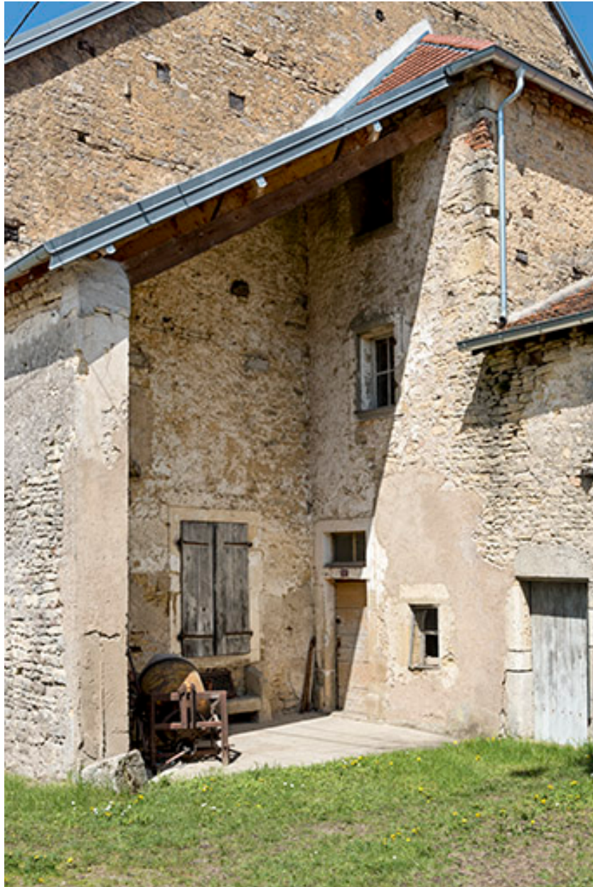
La partie abritée de la façade antérieure.
