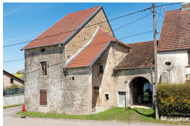
Vue générale. Phot. Sonia Dourlot IVR43_20167000549NUC4A
