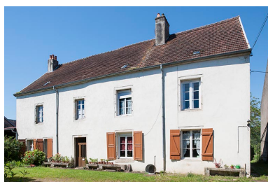
Château du village. Phot. Jérôme Mongreville IVR43_20167001022NUC4A
