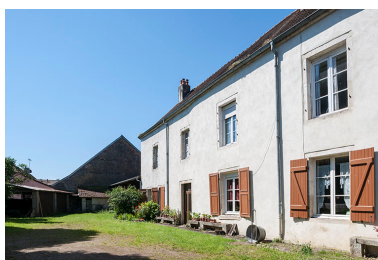
Château du village. Phot. Jérôme Mongreville IVR43_20167001023NUC4A
