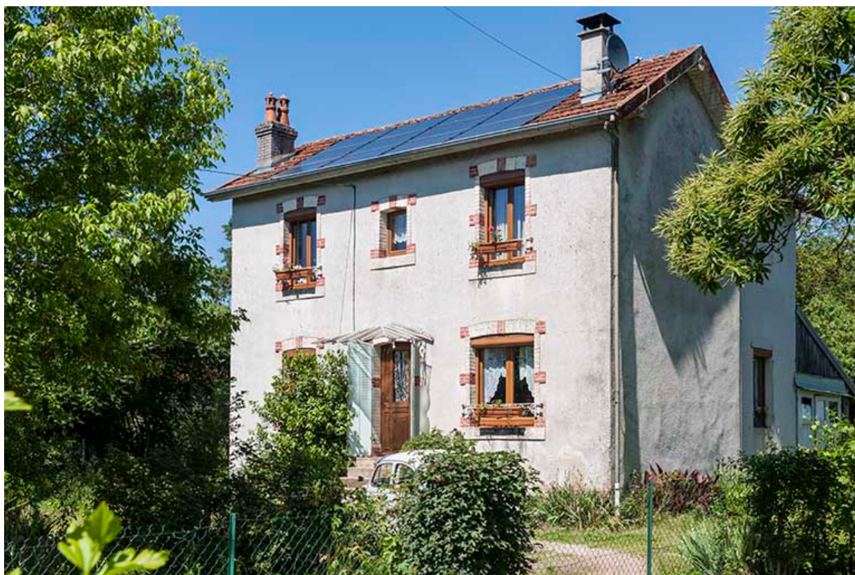
Maison située vers l'entrée du village.
