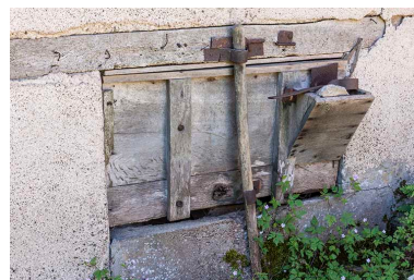
Détail de la soue. Phot. Jérôme Mongreville IVR43_20167001026NUC4A
