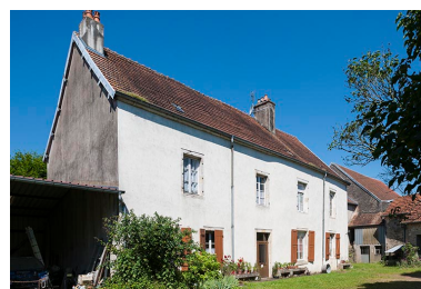
Château du village. Phot. Jérôme Mongreville IVR43_20167001025NUC4A
