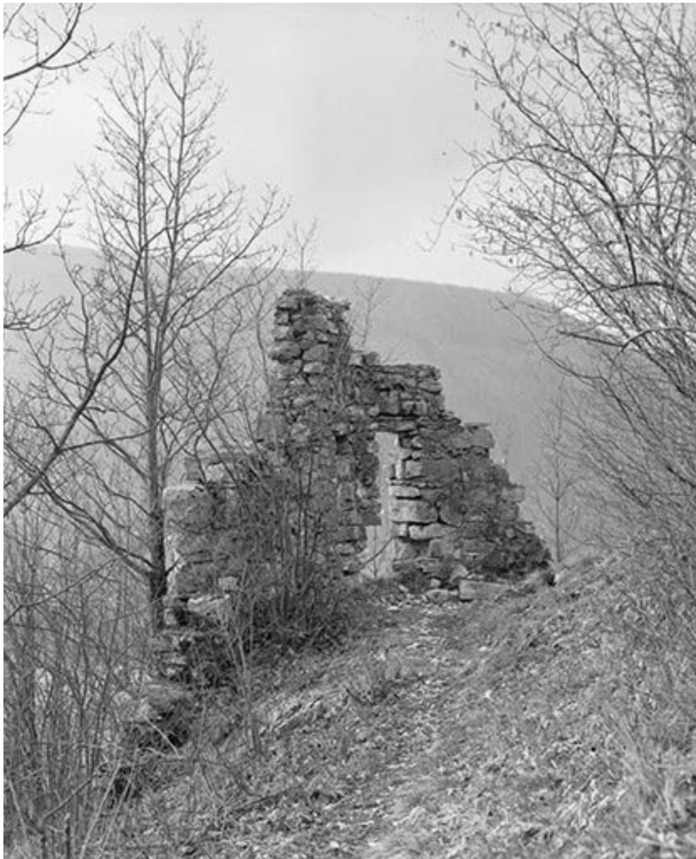
Détail : face interne de l'enceinte.
