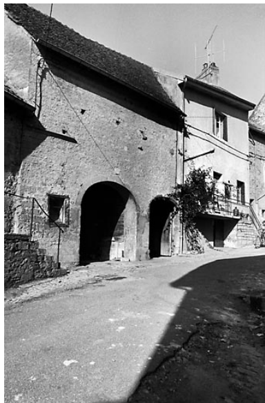
Vue d'ensemble en 1979. Phot. Bernard Lardière IVR43_19797000405Z
