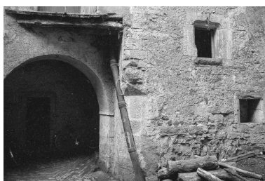
Accès à la tour d'escalier. Phot. Bernard Lardière IVR43_19797000407Z
