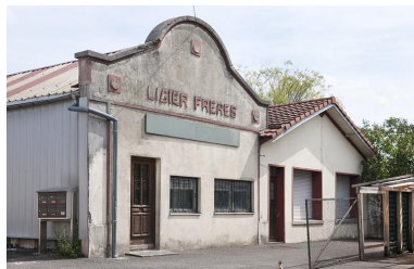
Pignon de l'atelier de fabrication original. Phot. Jérôme Mongreville IVR43_20112501145NUC4A
