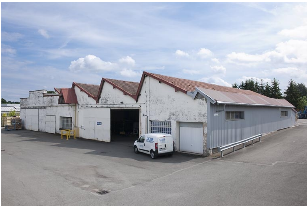
Atelier de fabrication ouest.
