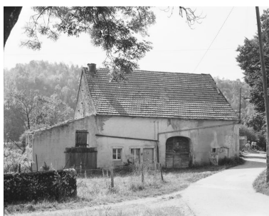
Façade antérieure. Phot. Yves Sancey
