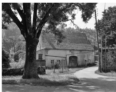
Façade antérieure. Phot. Yves Sancey
