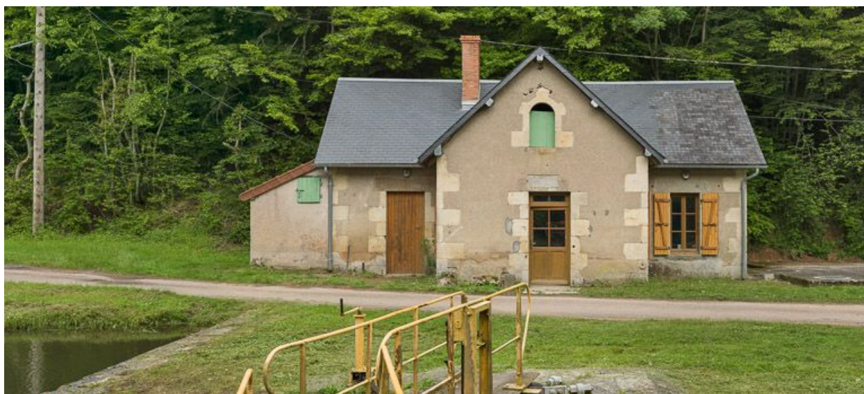
Vue de face de la maison éclusière.
