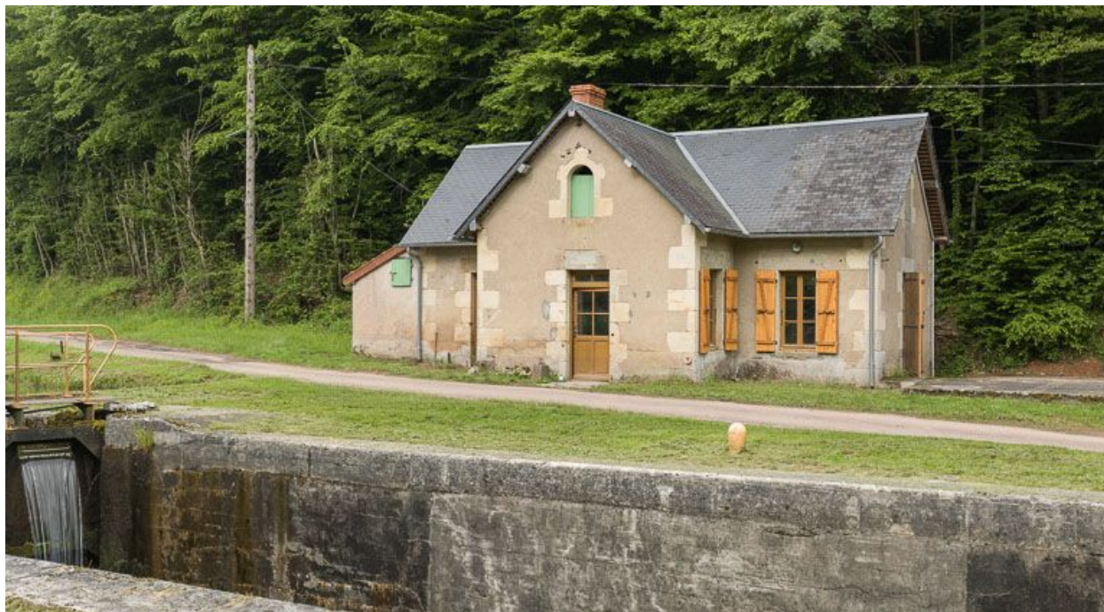
La maison éclusière de 3/4.
