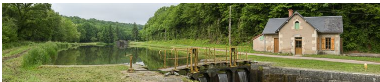
Vue d'ensemble du site d'écluse.
