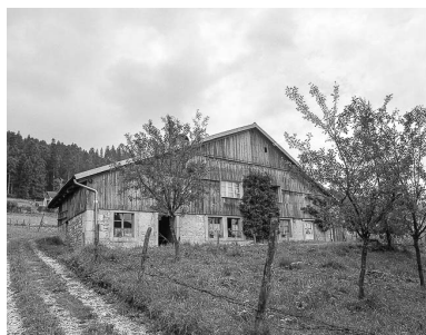
Ferme cadastrée 1966 AE 80 : façade antérieure. Phot. Dominique Humbert IVR43_19762500414X
