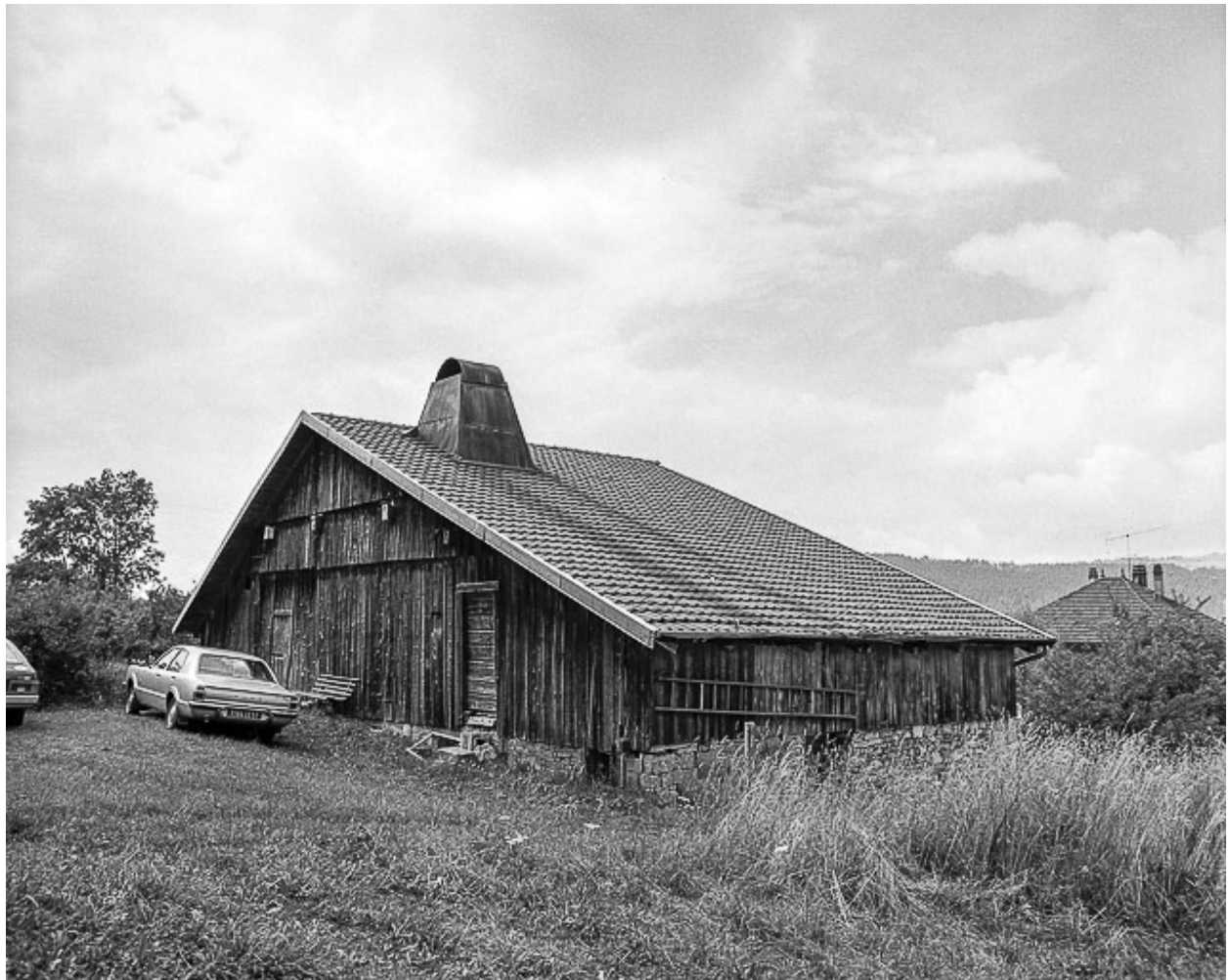
Ferme cadastrée 1966 AE 80 : façades postérieure et latérale gauche.
