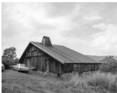
Ferme cadastrée 1966 AE 80 : façades postérieure et latérale gauche. Phot. Dominique Humbert IVR43_19762500415X
