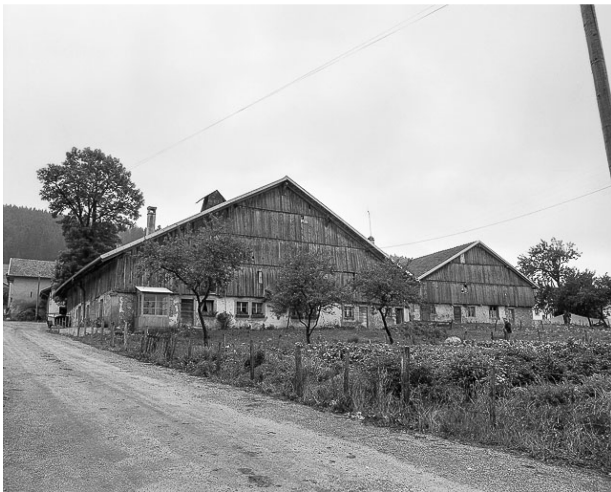
Fermes situées au lieudit Chinard : façades antérieures.
