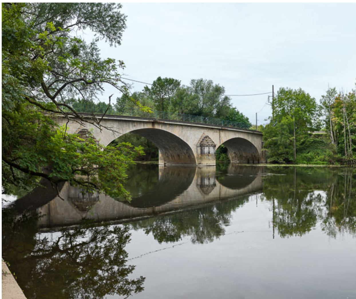
Vue d'ensemble du pont.
