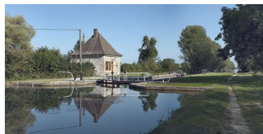
Vue d'amont. Phot. Thierry Kuntz IVR26_20112103145NUC4A
