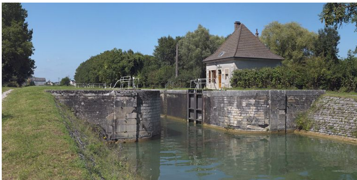
Site vu d'aval.
