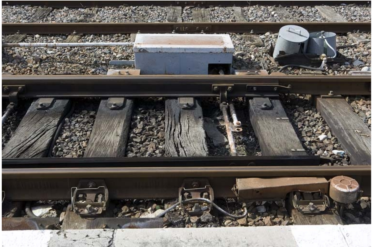
Exemple de rampe de réchauffage au gaz, sur un autre appareil (rampe partiellement démontée).
