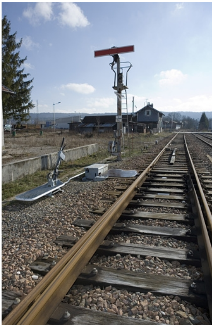
Vue d'ensemble, depuis le côté Andelot-en-Montagne.
