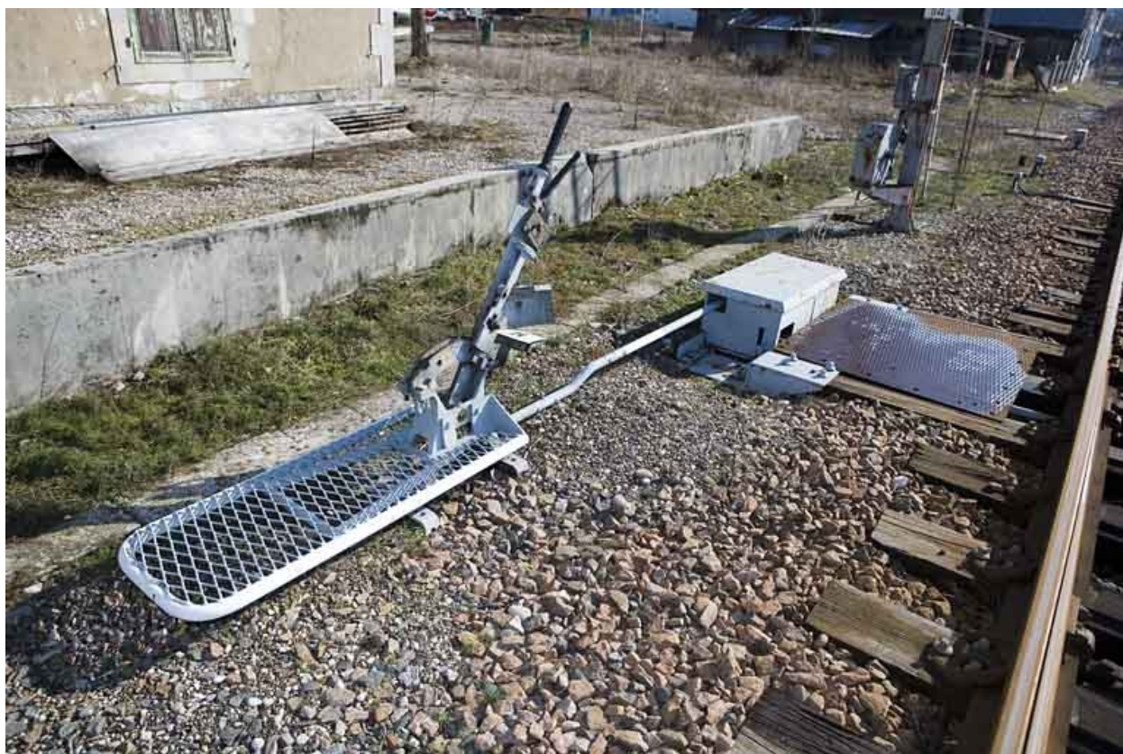
Levier de manoeuvre et boîte de protection du renvoi d'angle.
