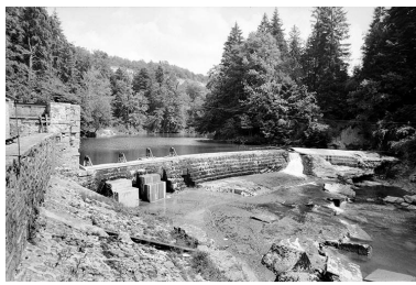
Barrage. Phot. Laurent Poupard IVR43_19923901436Z
