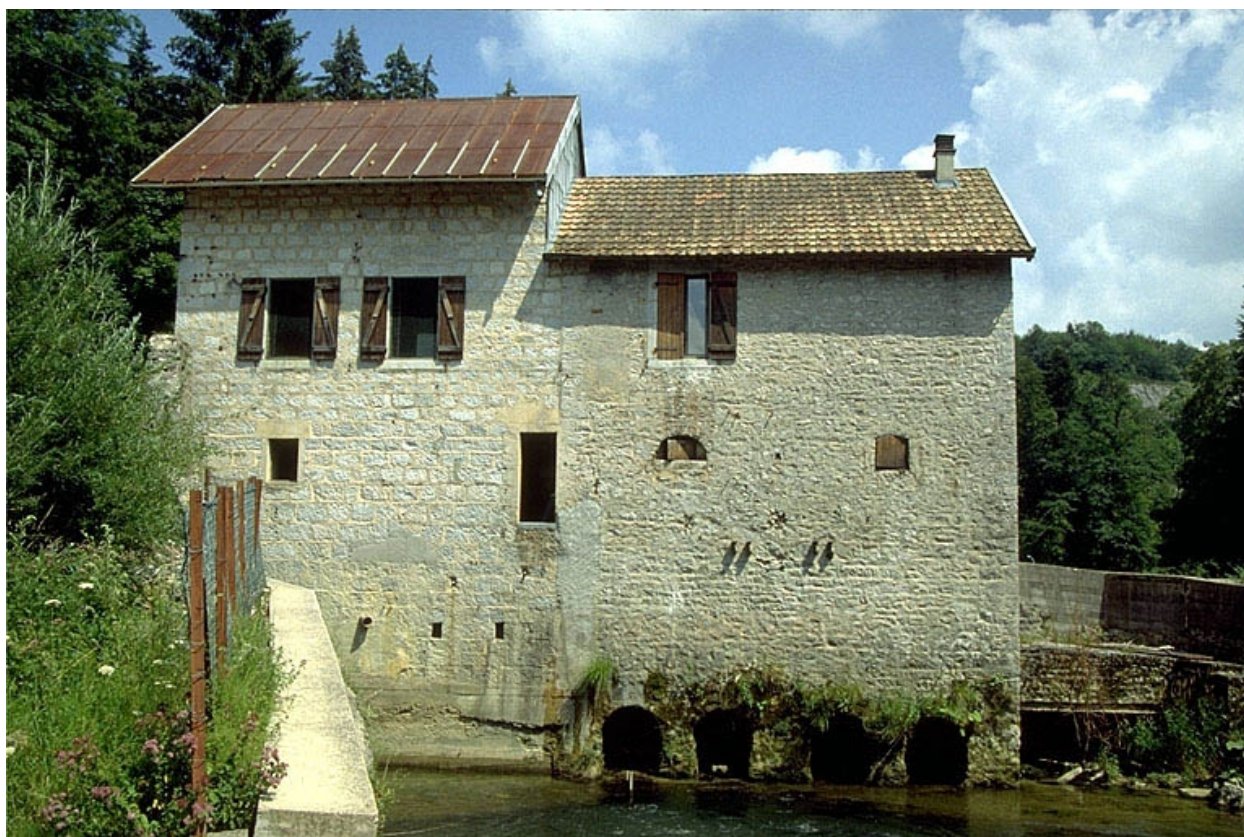
Façade latérale droite.
