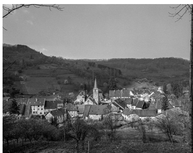
Vue générale du village depuis l'est. Phot. Jérôme Mongreville IVR43_19853900147X
