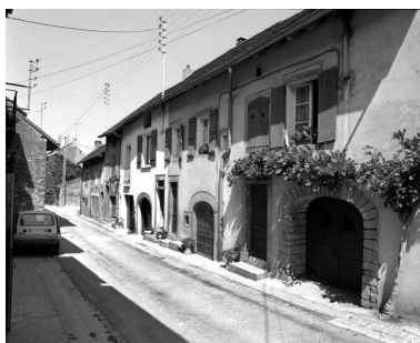
Maison de vigneron située rue des Vignerons. Phot. Yves Sancey IVR43_19843900344X
