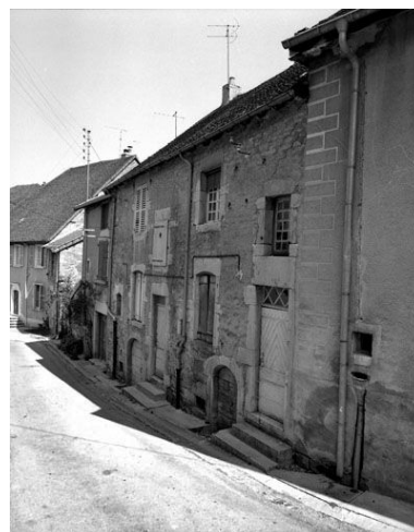
Maison de vigneron située rue des Vignerons. Phot. Yves Sancey IVR43_19843900343X
