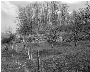
Vestiges du château fort. Phot. Jérôme Mongreville IVR43_19853900152X
