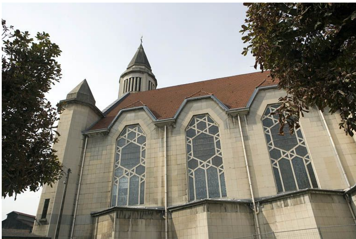
Vue extérieure de la nef.
