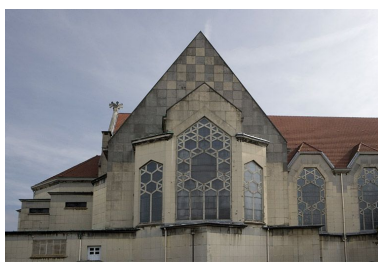
Chevet d'une chapelle. Phot. Yves Sancey IVR43_20062500709NUCA
