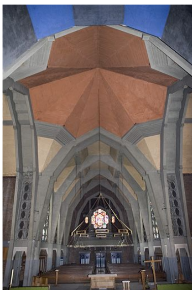
Plafond du transept. Phot. Yves Sancey IVR43_20062500690NUCA
