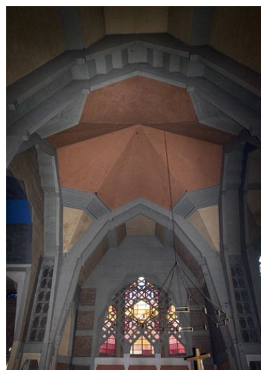
Plafond du transept. Phot. Yves Sancey IVR43_20062500708NUCA
