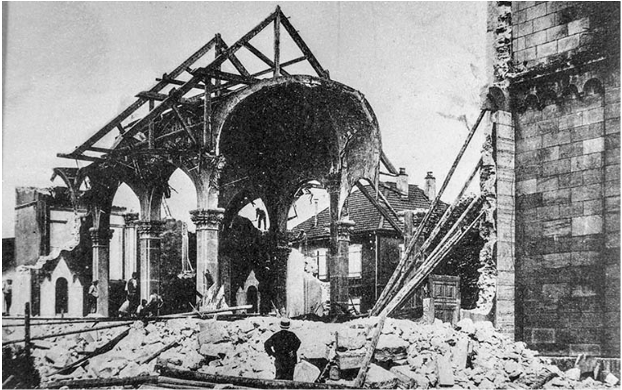
Chantier de construction, 1931.
