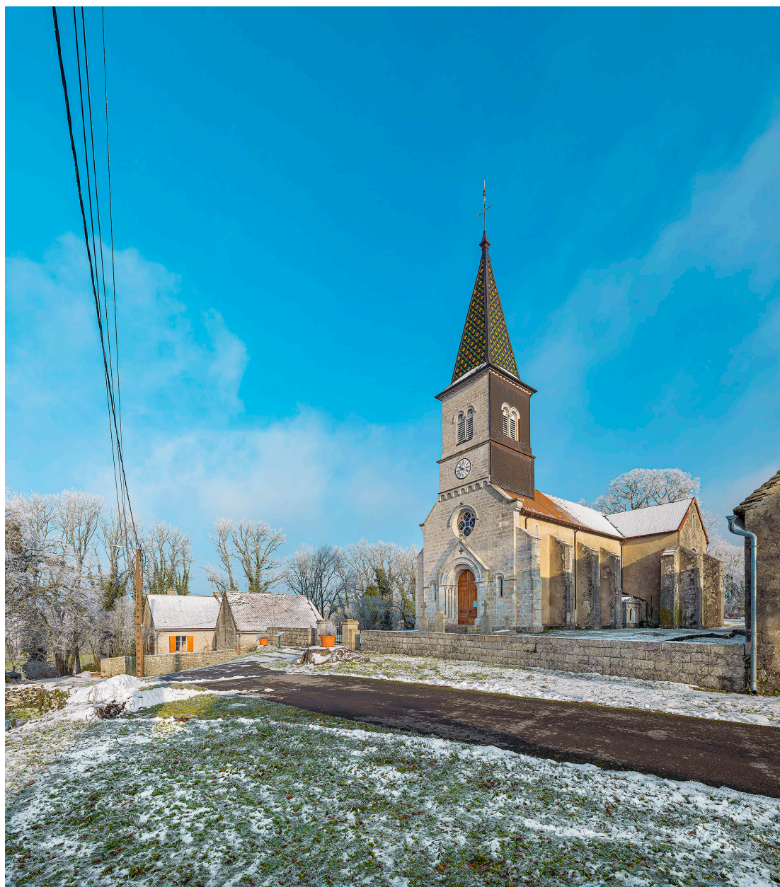
Vue d'ensemble de l'église, dans son environnement.
