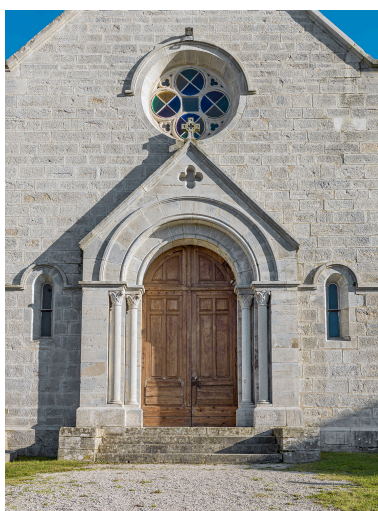
Façade principale, détail : portail. Phot. Thierry Kuntz IVR43_20243901255NUC4A
