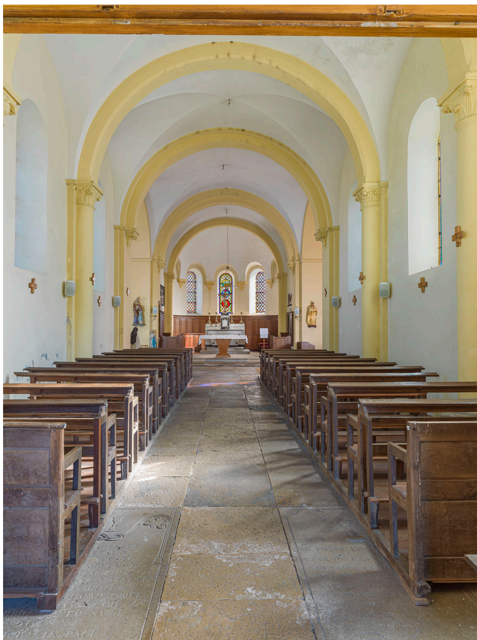
Vue d'ensemble de la nef et du chœur depuis le porche.
