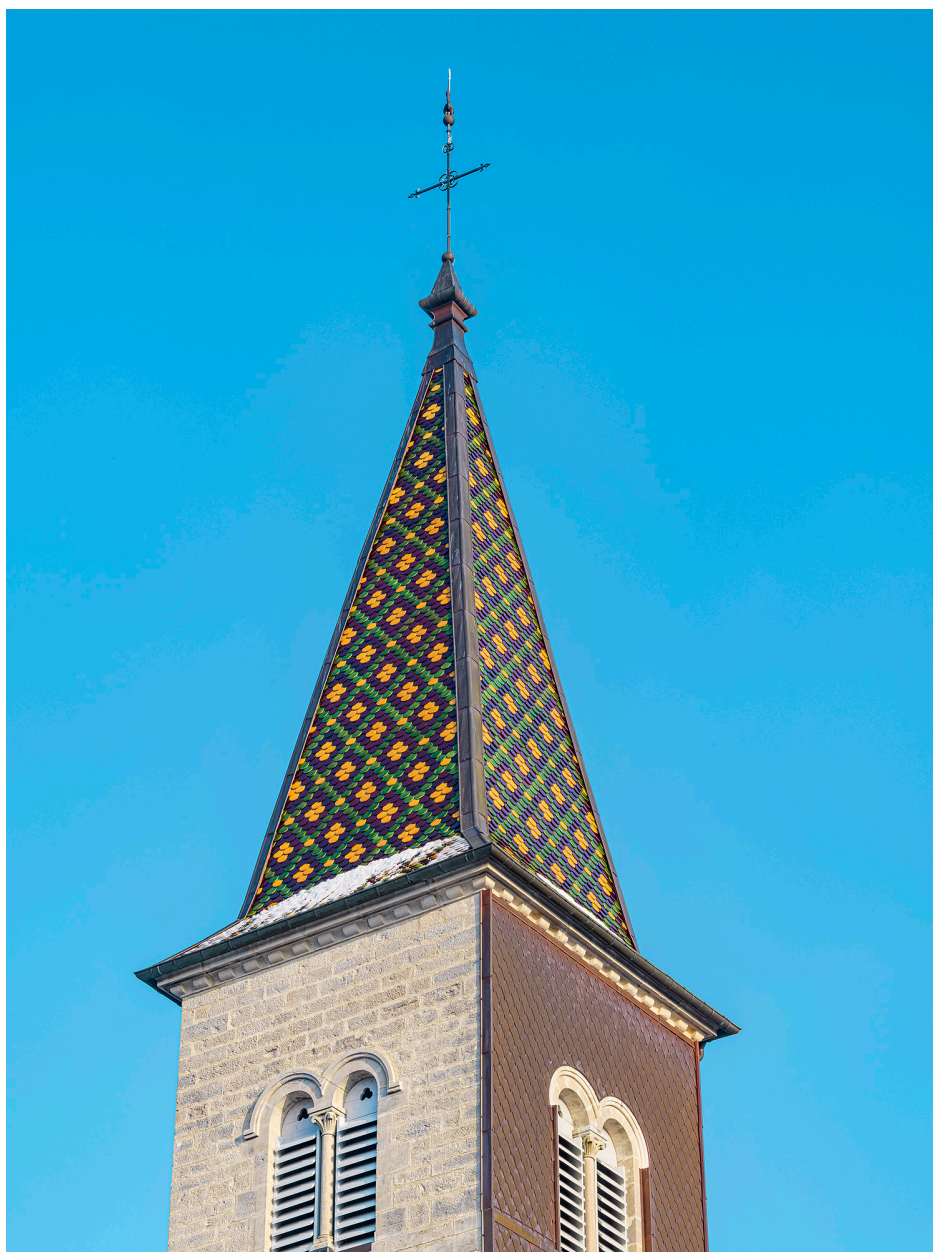
Baies géminées et flèche du clocher.
