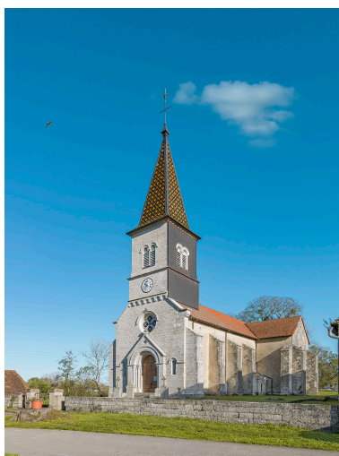
Façade principale et élévation sud. Phot. Thierry Kuntz IVR43_20243901257NUC4A
