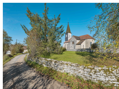
Vue d'ensemble : élévation sud et chevet. Phot. Thierry Kuntz IVR43_20243901259NUC4A
