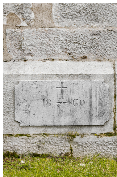
Façade principale, détail : date portée. Phot. Thierry Kuntz IVR43_20253900008NUC4A
