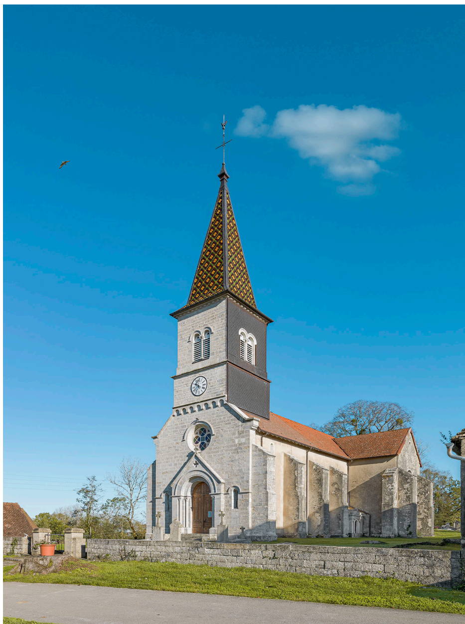
Façade principale et élévation sud.
