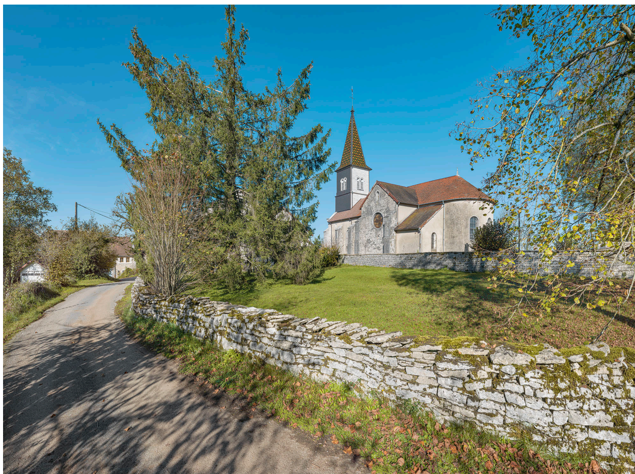
Vue d'ensemble : élévation sud et chevet.
