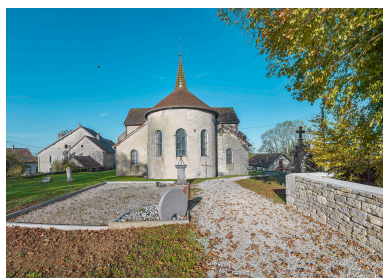
Vue d'ensemble du chevet, depuis le cimetière. Phot. Thierry Kuntz IVR43_20243901263NUC4A
