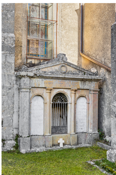
Mausolée adossé au mur sud de la nef. Phot. Thierry Kuntz
