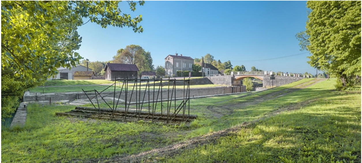
Vue d'ensemble du site. Au premier plan, vestiges des fermettes métalliques de l'ancien barrage mobile du Châtelet.
