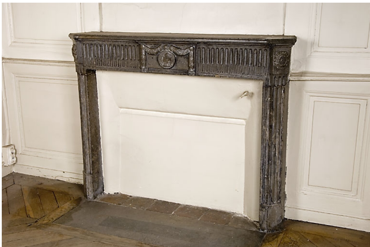
Détail d'une cheminée : pièce au rez-de-chaussée.
