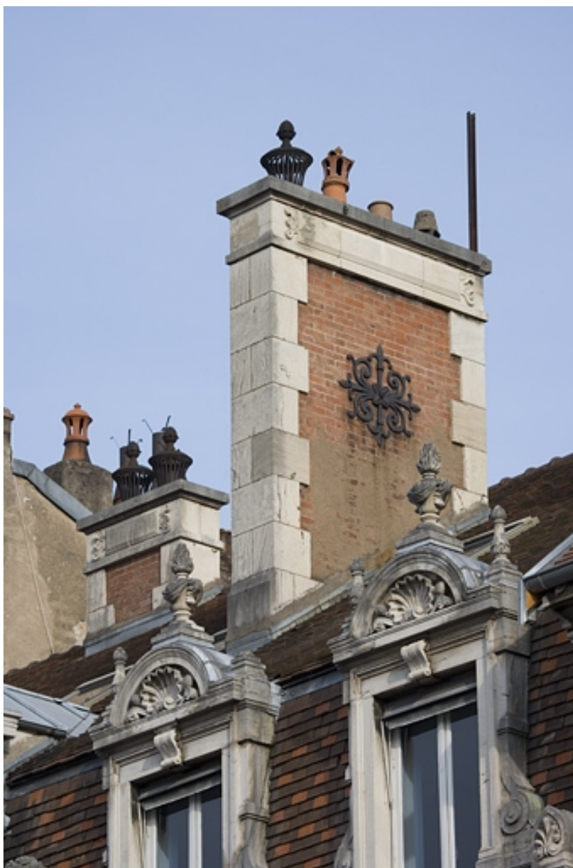
Détail d'une souche de cheminée.
