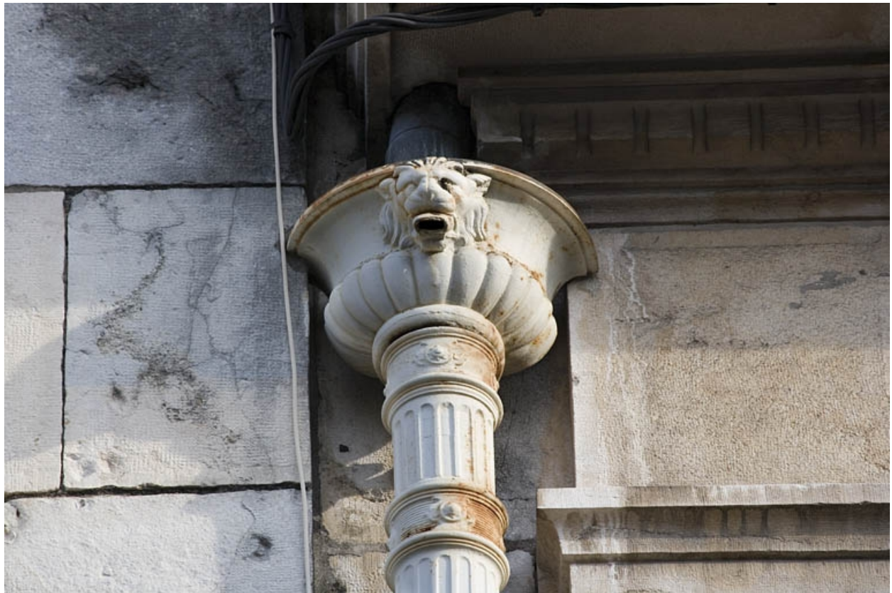
Détail d'une cuvette de descente des eaux.
