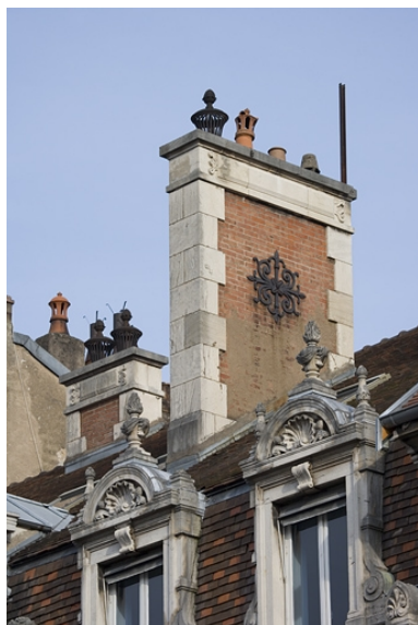
Détail d'une souche de cheminée. Phot. Yves Sancey IVR43_20072500394NUCA
