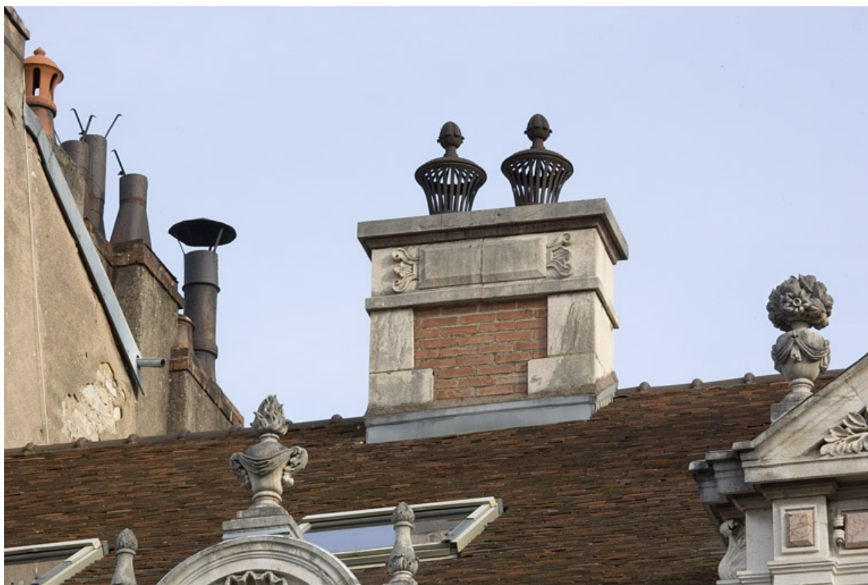
Détail d'une souche de cheminée.
