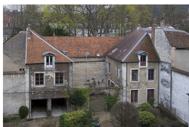
Vue d'ensemble des bâtiments des communs. Phot. Yves Sancey IVR43_20072500374NUCA
