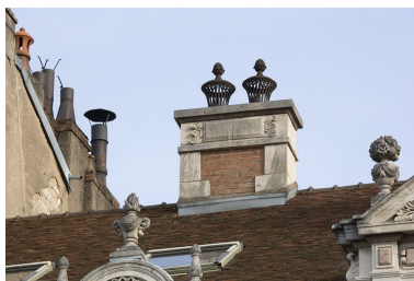
Détail d'une souche de cheminée. Phot. Yves Sancey IVR43_20072500393NUCA
