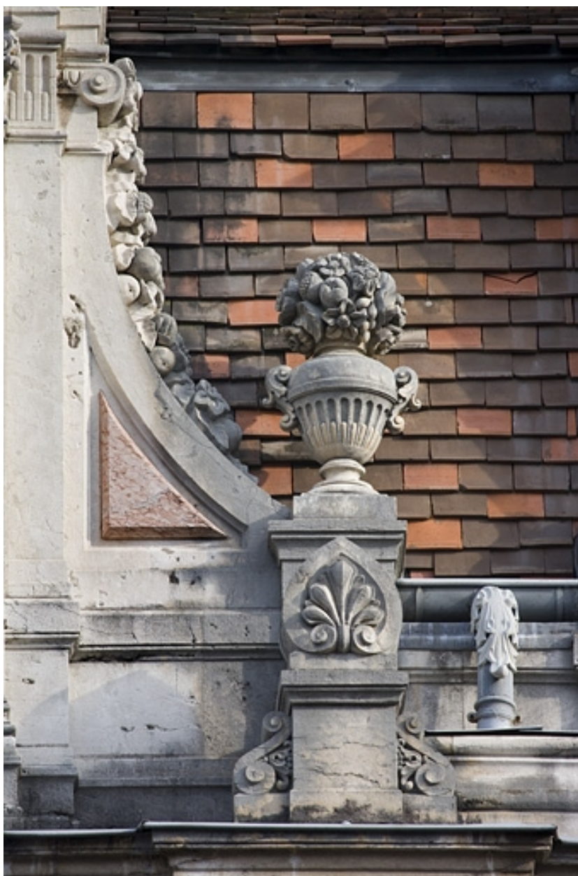
Détail de l'aileron droit d'une lucarne.
