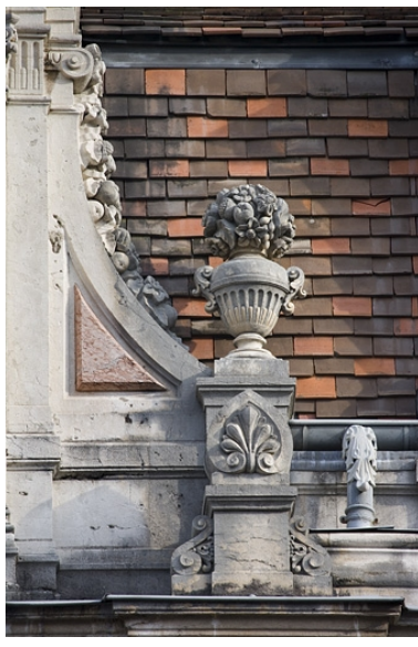
Détail de l'aileron droit d'une lucarne. Phot. Yves Sancey IVR43_20072500391NUCA
