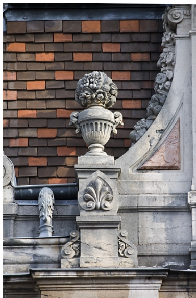
Détail de l'aileron gauche d'une lucarne. Phot. Yves Sancey IVR43_20072500392NUCA
