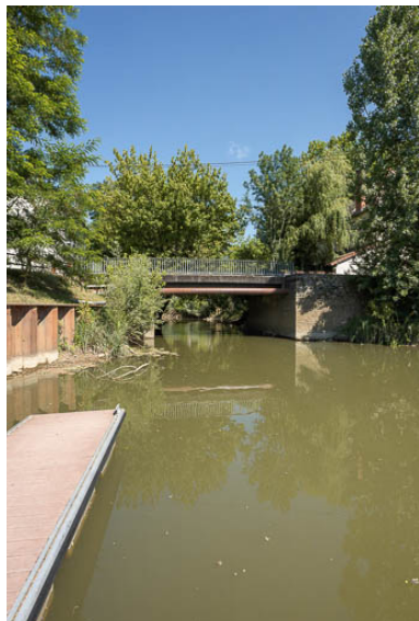
Vue d'ensemble du pont.
