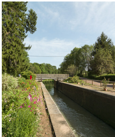
Vue du sas et du pont. Phot. Pierre-Marie Barbe-Richaud IVR26_20175800145NUC2A
