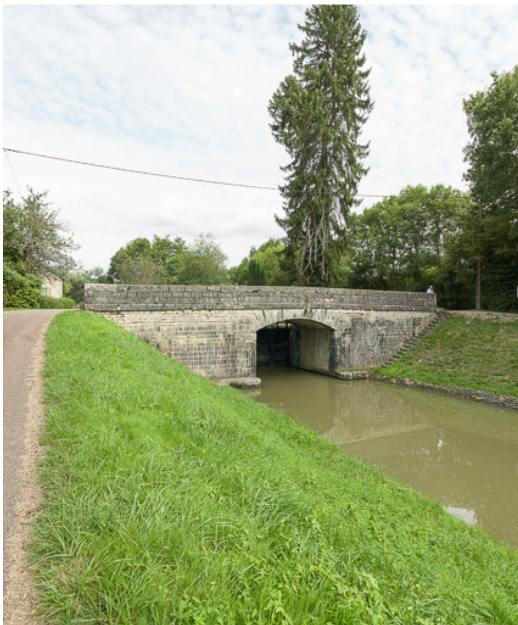
Vue d'ensemble du pont.
