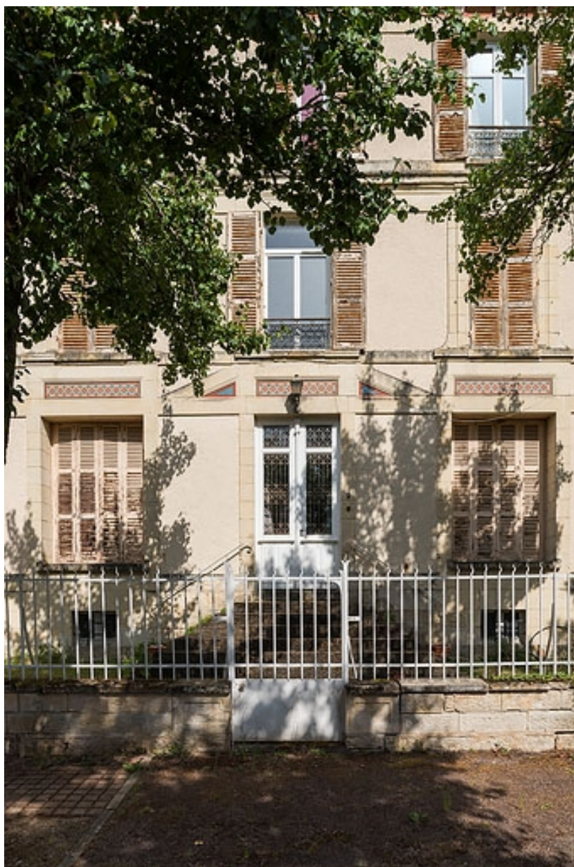
Façade ouest, détail avec la porte d'entrée.
