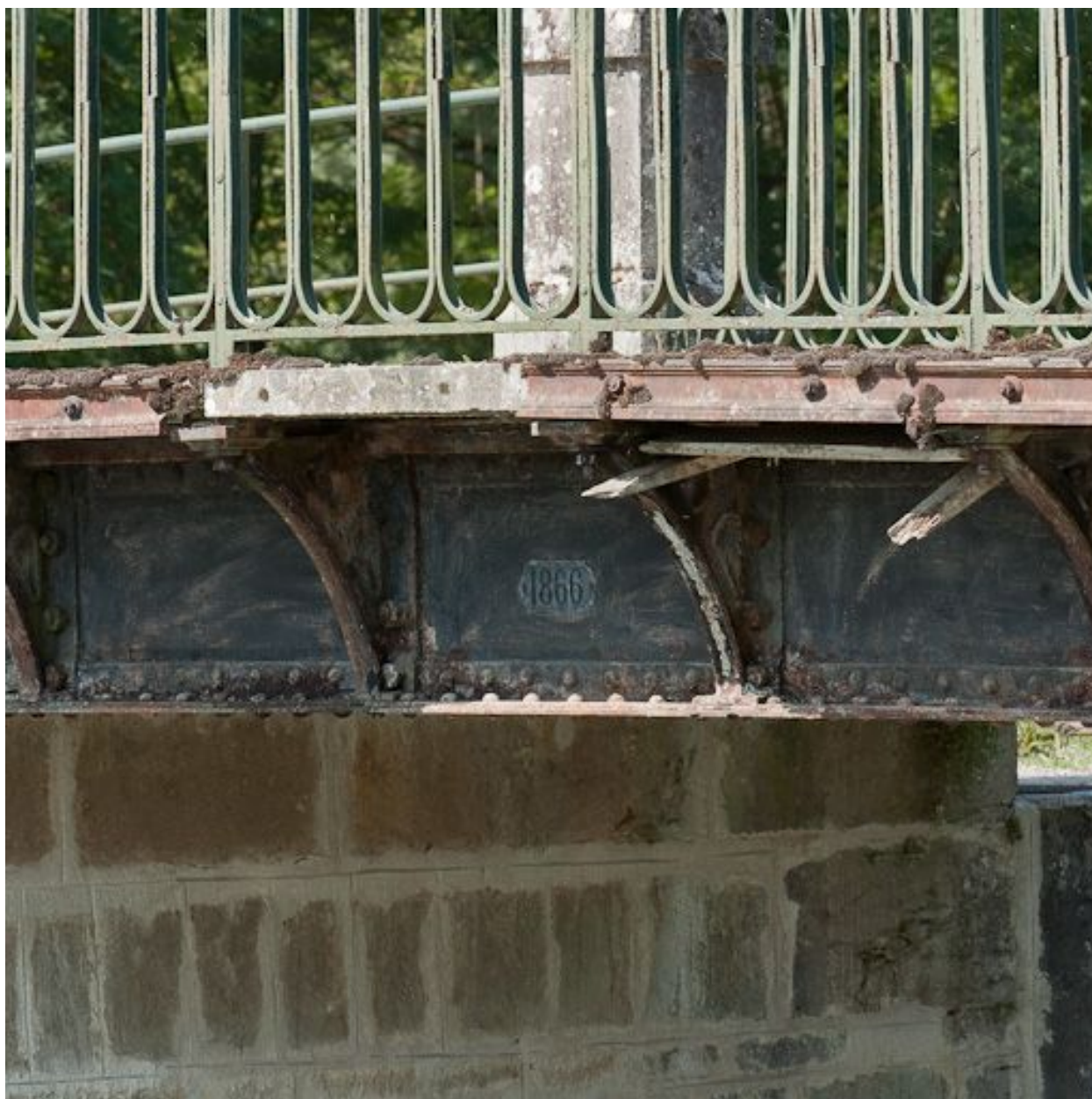
Détail du pont sur écluse.
