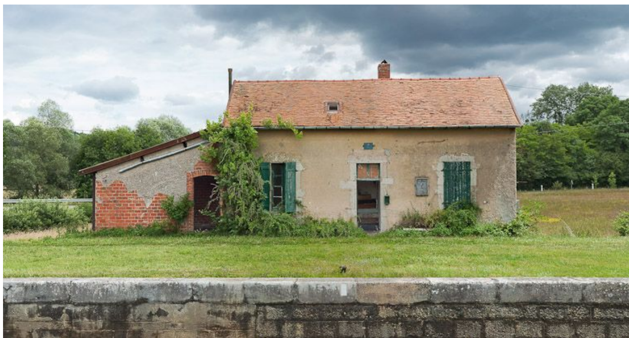
Vue de face de la maison éclusière.
