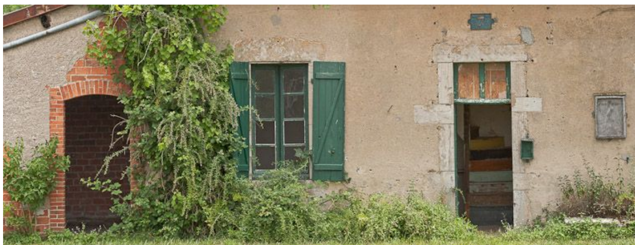
Détail des baies de la maison éclusière.
