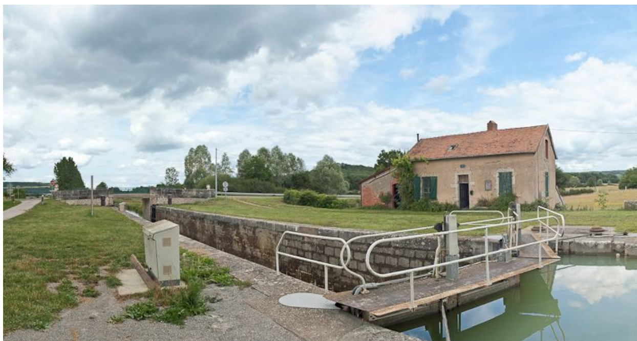
Vue d'ensemble du site d'écluse.
