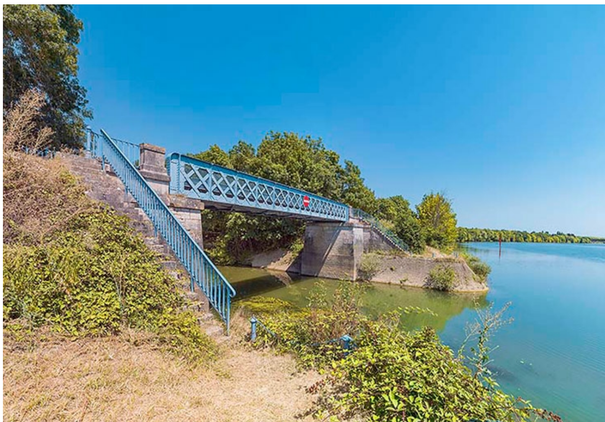
Vue d'ensemble du pont sur la Dheune.
