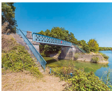
Vue d'ensemble du pont sur la Dheune. Phot. Thierry Kuntz IVR26_20207100277NUC4A
