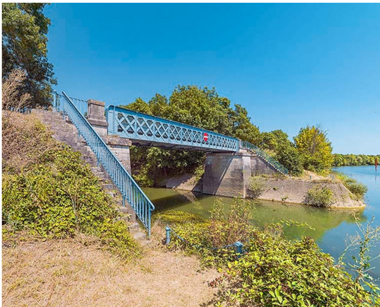
Vue d'ensemble du pont sur la Dheune.
