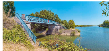
Vue d'ensemble du pont sur la Dheune. Phot. Thierry Kuntz IVR26_20207100275NUC4A
