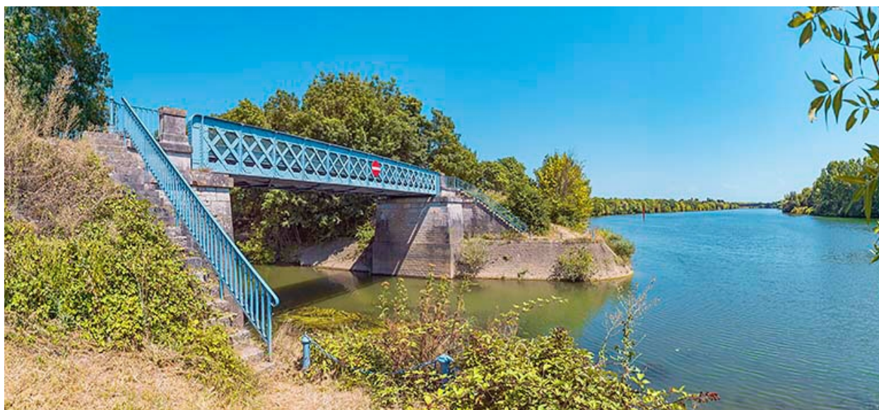
Vue d'ensemble du pont sur la Dheune.
