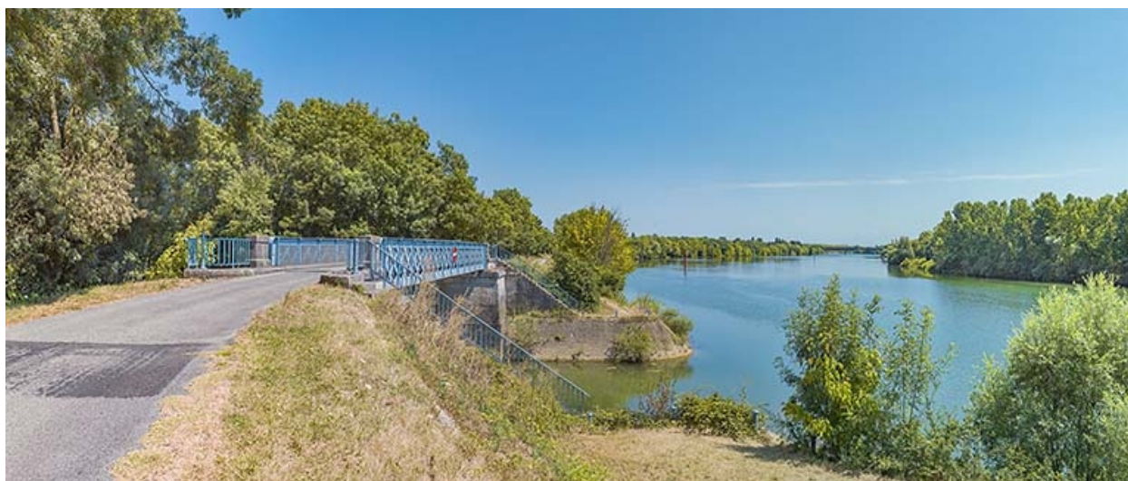
Le pont sur la Dheune, vu d'aval.
