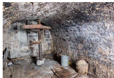
Intérieur de la cave en sous-sol. Phot. Sonia Dourlot IVR43_20172500688NUC4A
