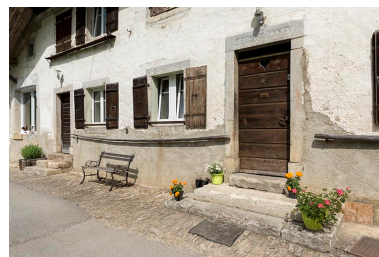
Façade antérieure : portes et fenêtres au rez-de-chaussée. Phot. Sonia Dourlot IVR43_20172500683NUC4A
