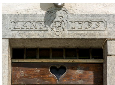
Façade antérieure : linteau daté 1799. Phot. Sonia Dourlot IVR43_20172500681NUC4A
