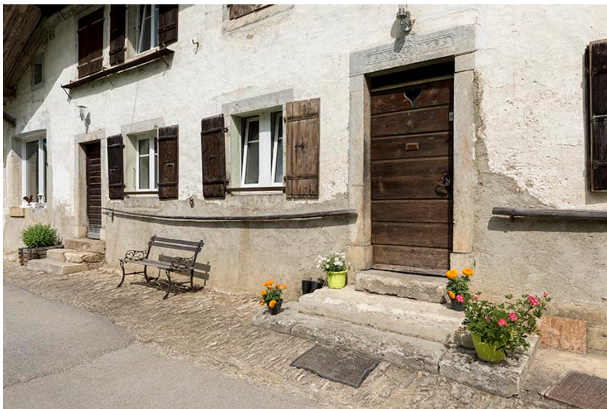
Façade antérieure : portes et fenêtres au rez-de-chaussée.
