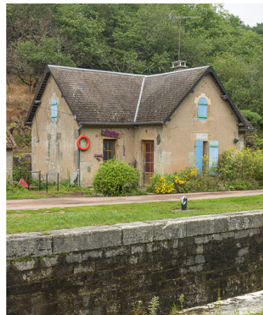
Vue de la maison éclusière. Phot. Pierre-Marie Barbe-Richaud IVR26_20175800269NUC2A
