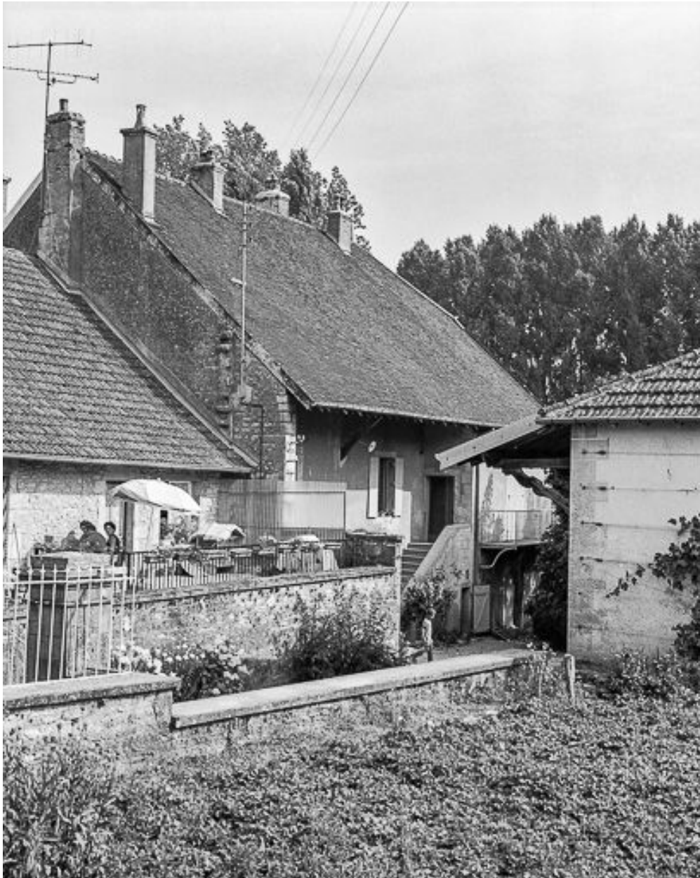
Maison de vigneron située route de Courbouzon au Petit Messia.
