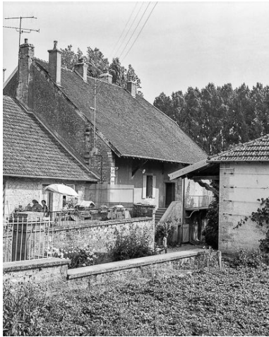
Maison de vigneron située route de Courbouzon au Petit Messia. Phot. Yves Sancey IVR43_19843900271X
