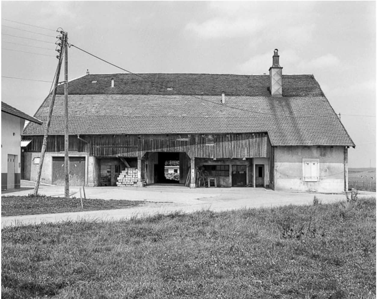
Façade latérale droite d'une ferme.
