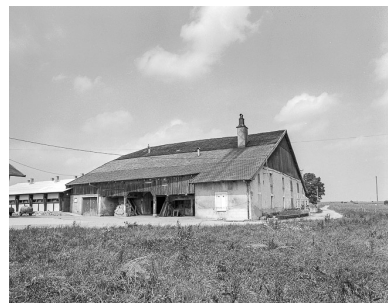
Ferme vue de trois quarts. Phot. Dominique Dominguez IVR43_19792500820X
