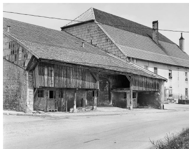
Façade sur rue d'une ferme. Phot. Dominique Dominguez IVR43_19792500815X
