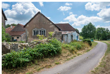
Mur pignon ouest. Phot. Jérôme Mongreville IVR43_20177001010NUC4A
