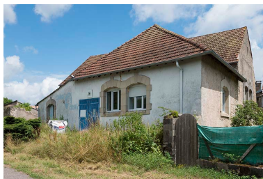
Façade postérieure. Phot. Jérôme Mongreville IVR43_20177001011NUC4A
