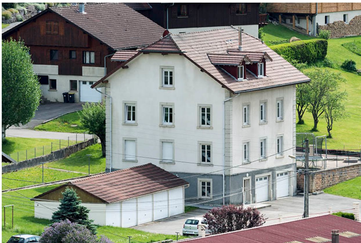
Façades postérieure et latérale gauche.
