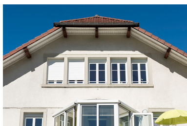
Fenêtres multiples sur la façade antérieure. Phot. Sonia Dourlot IVR43_20172500420NUC4A
