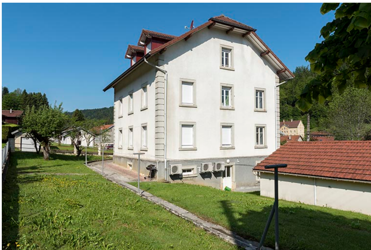
Façades postérieure et latérale droite.
