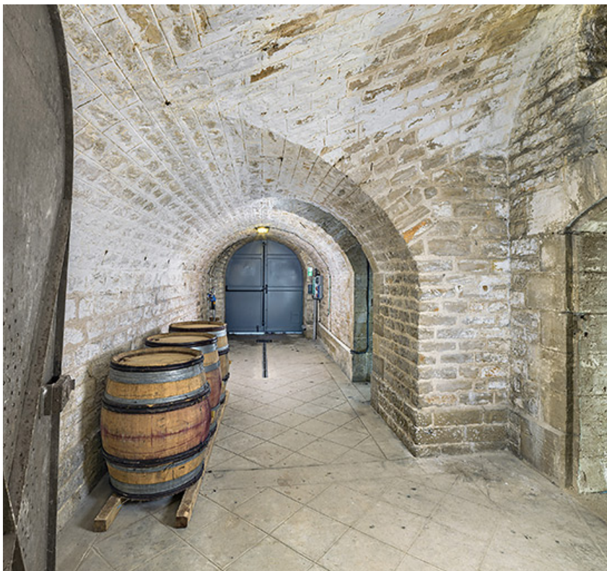
La porte d'entrée : vue depuis la galerie d'assainissement.
