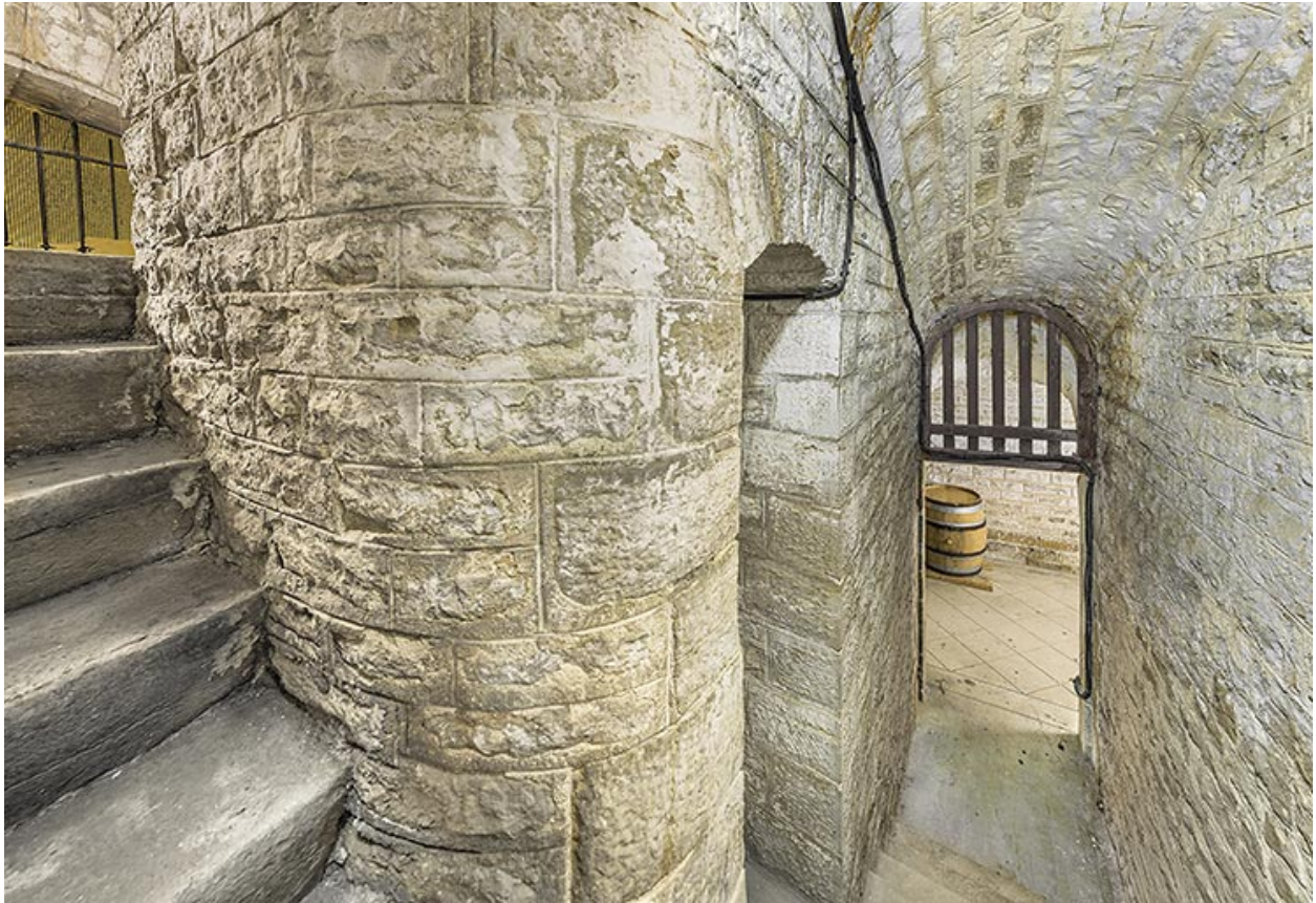
L'escalier d'accès à la chambre d'éclairage au-dessus du vestibule d'entrée.
