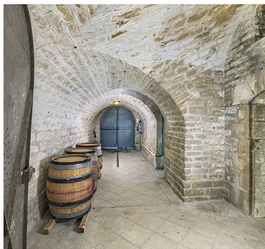
La porte d'entrée : vue depuis la galerie d'assainissement. Phot. Thierry Kuntz IVR26_20252100432NUC4A
