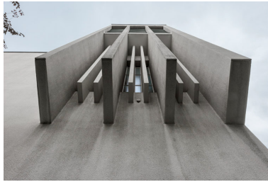
Détail du jeu de pilastres formant la console du clocher et des meneaux en béton armé (baie 102). Phot. Pierre-Marie Barbe-Richaud IVR26_20227100220NUC4A
